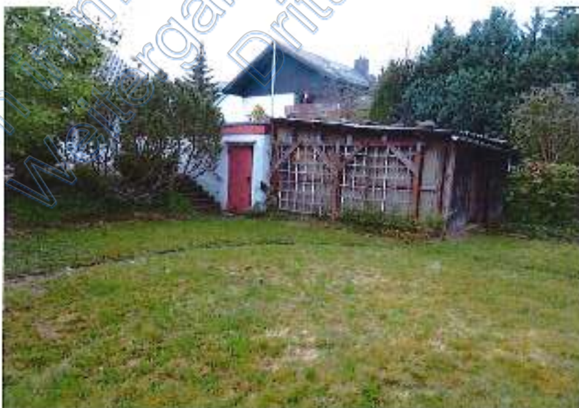
Foto 8: Garage mit Schuppenanbau
