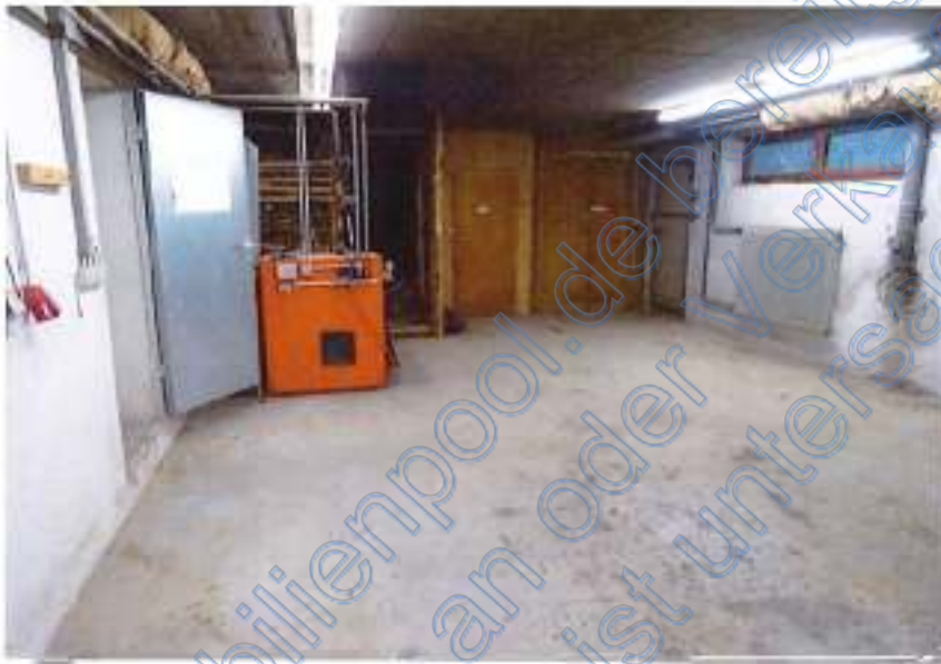
Foto 10: Ehemalige Werkstatt mit Feststoffheizanlage
