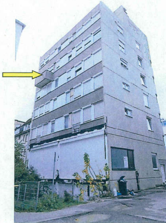
Blick von Nordwesten auf das Gebäude. Der gelbe Pfeil zeigt auf den Balkon der zu bewertenden Wohnung Nr. 5 im 4. Obergeschoss.
