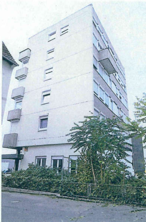
Ansicht des Gebäudes vom Nachbargrundstück aus Richtung Nordosten.
