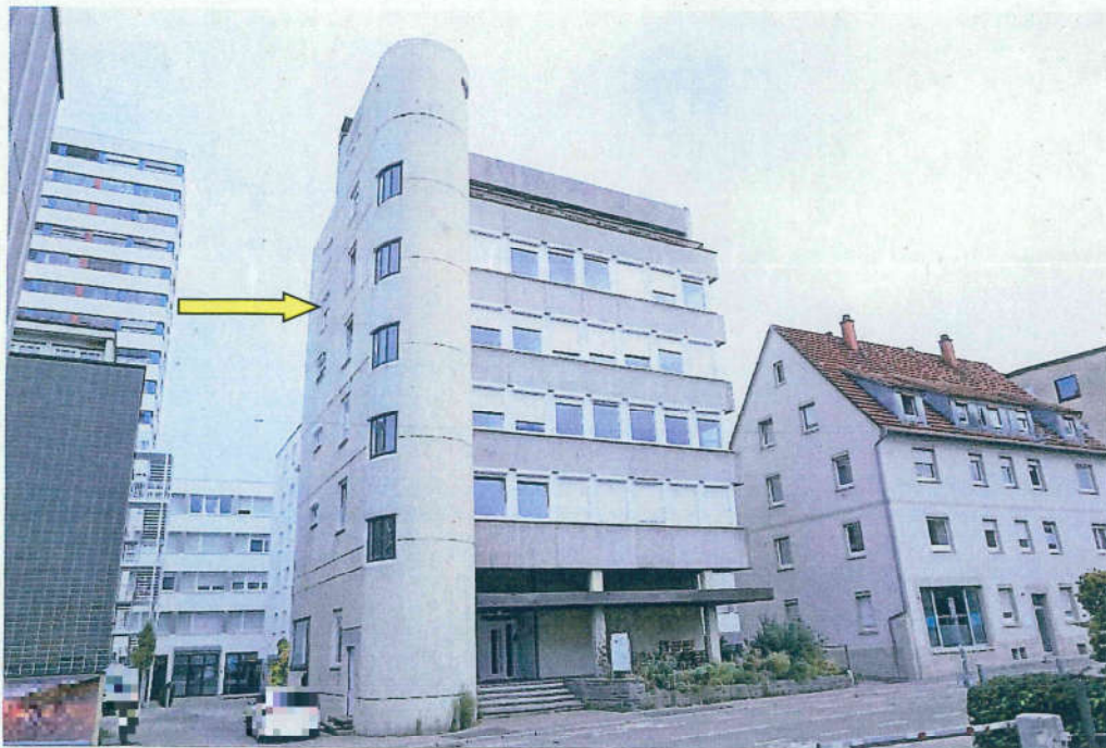
Blick auf das Wohn- und Geschäftshaus von Südwesten. Der gelbe Pfeil zeigt auf das Fenster des Zimmers Nr. 3. Rechts daneben befindet sich das Fenster des Zimmers Nr. 4.
