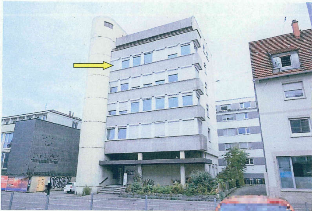
Blick auf das Gebäude Karlstraße 33 auf dem Flst. Nr. 522/2 von Süden aus. Der gelbe Pfeil zeigt auf eines der beiden Fenster des Zimmers Nr. 1. Rechts daneben befinden sich die beiden Fenster des Zimmers Nr. 2 und die drei Fenster der Küche.
