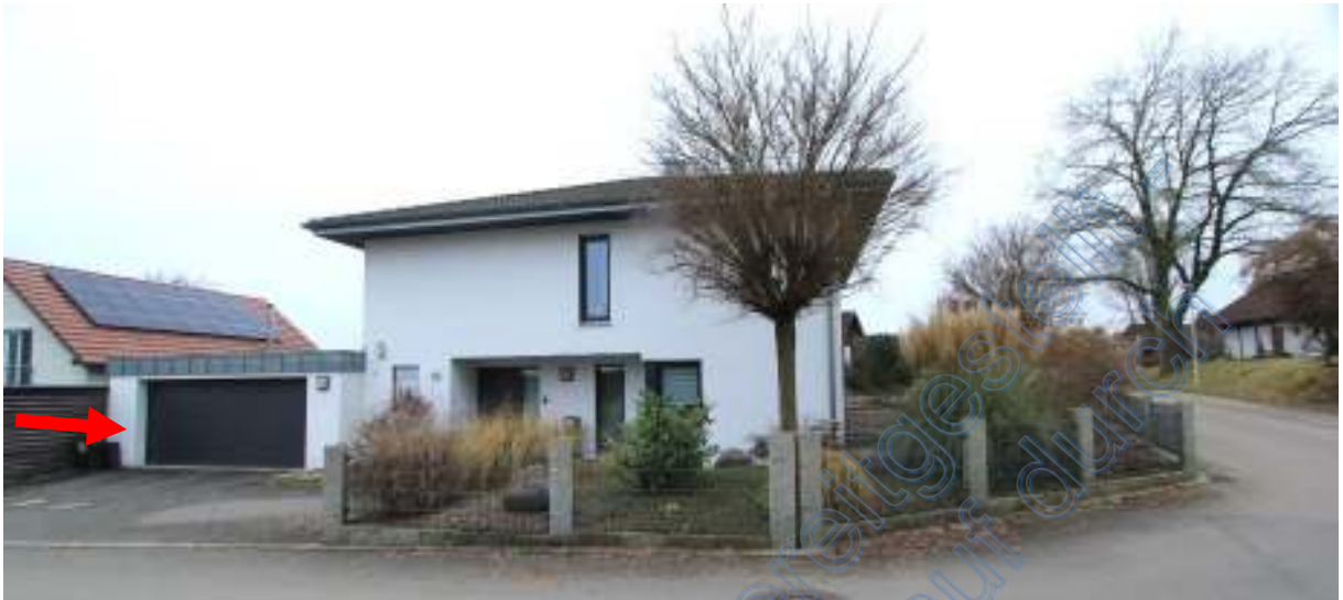
Grundstück mit Doppelgarage und Wohnhaus von Nord/Nordosten
