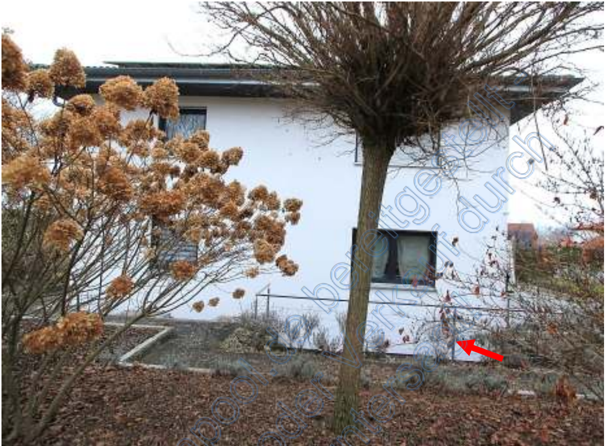
Westfassade Wohnhaus mit Edelstahlgeländer vor dem Lichthof
