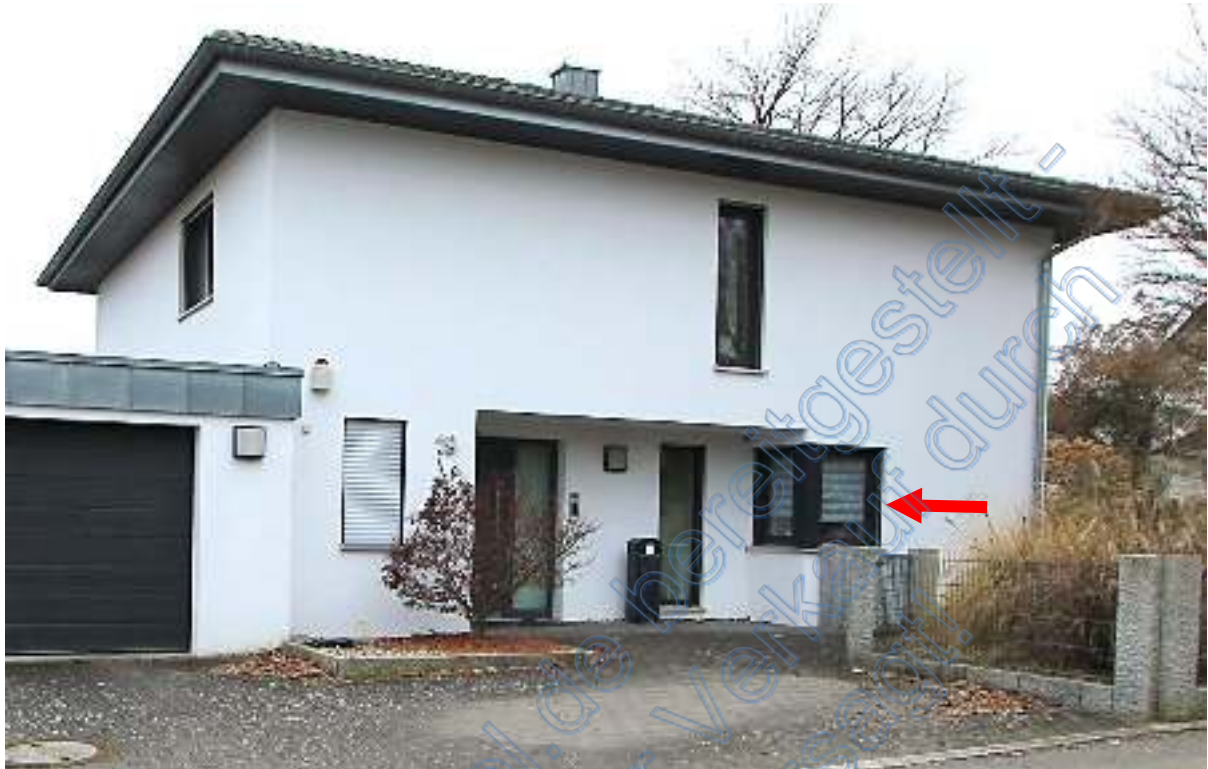
Wohnhaus mit überdachtem Hauseingang von Norden, Pfeil Küchenfenster
