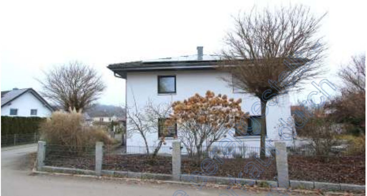
Grundstück mit Wohnhaus von Westen
