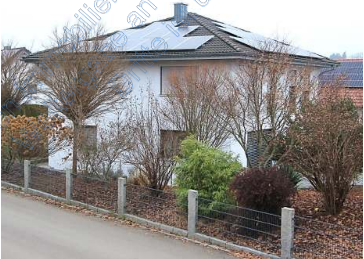
Wohnhaus von Südwesten
