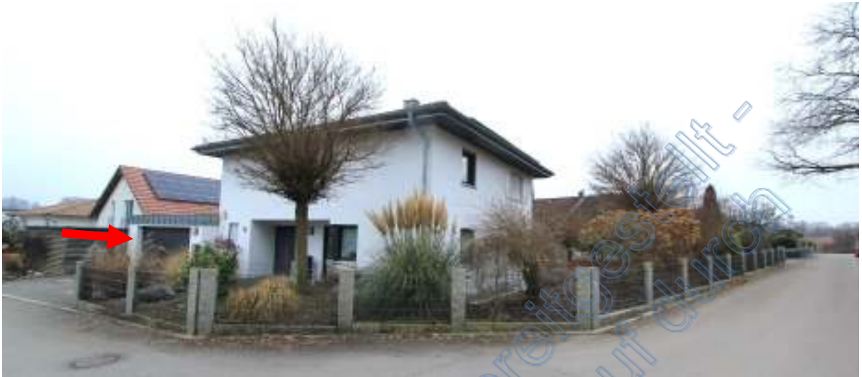
Grundstück mit Doppelgarage und Wohnhaus von Nordwesten
