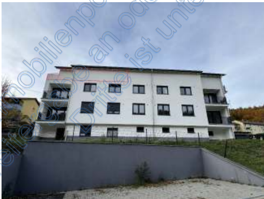
Bild 2: Gebäudeansicht von Südosten mit rot markiertem Bewertungsobjekt
