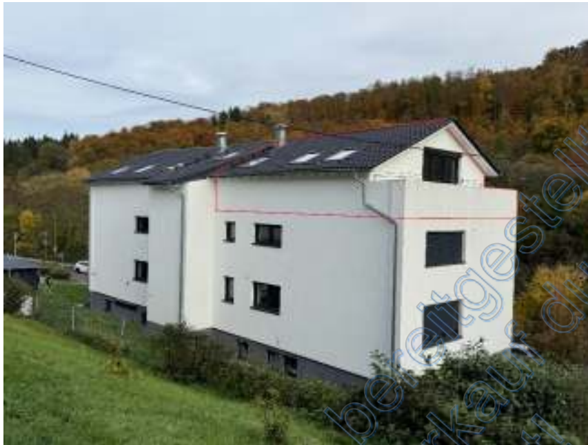
Bild 1: Gebäudeansicht von Südwesten mit rot markiertem Bewertungsobjekt
