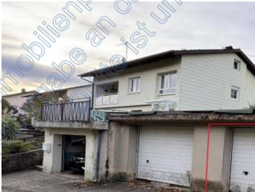
Bild 16: Garagenstellplatz "Gar 1" (rot markiert) als Sondernutzungsrecht
