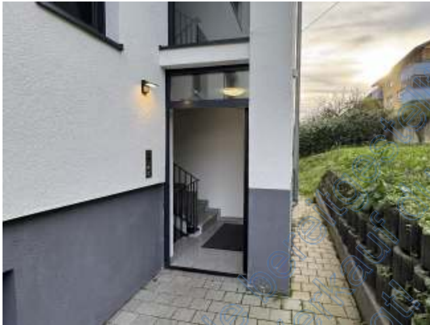
Bild 3: Zugang zum Gebäude
