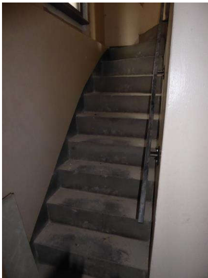
15. Treppe zum OG
