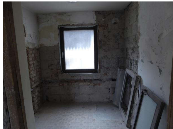
16. Ehem. Bad, vorgesehen Küche
