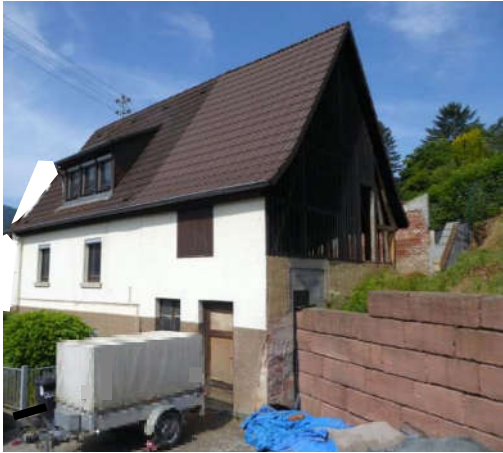
1. Blick von Nordosten
