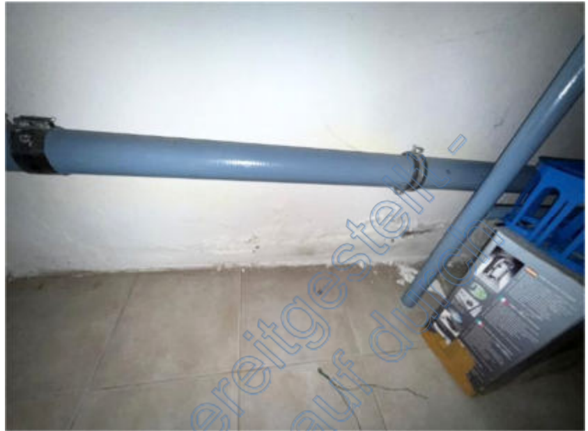
Abb. 5: Foto des SV; z.T. Feuchteschäden in unteren Wandbereichen (KG)
