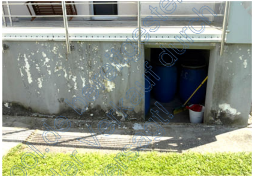
Abb. 3: Foto des SV; z.T. Feuchteschäden in Wandbereichen unter Terrasse
