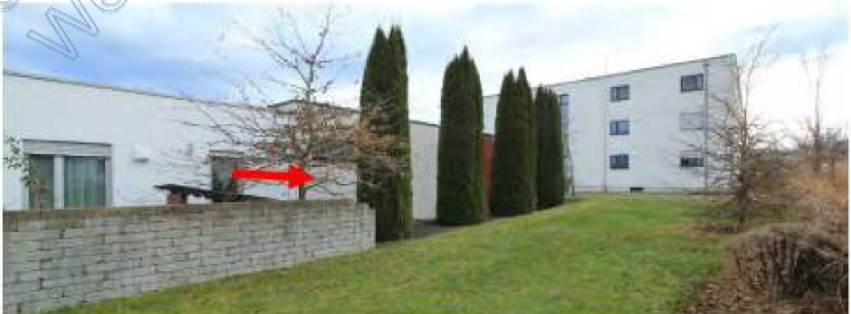
Blick von Nordwesten, Pfeil Bungalow, rechts davon Rasenfläche
