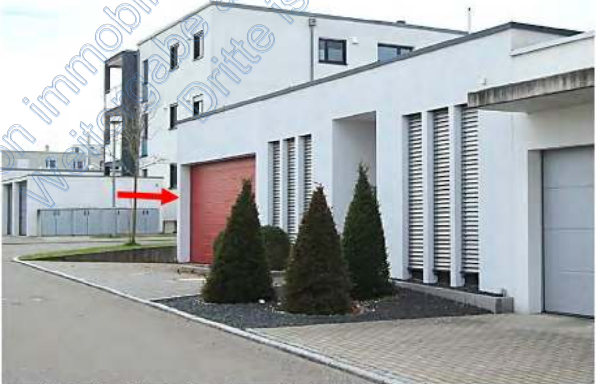
Grundstück mit Ostseite des Bungalows von Nordosten, Pfeil Doppelgarage
