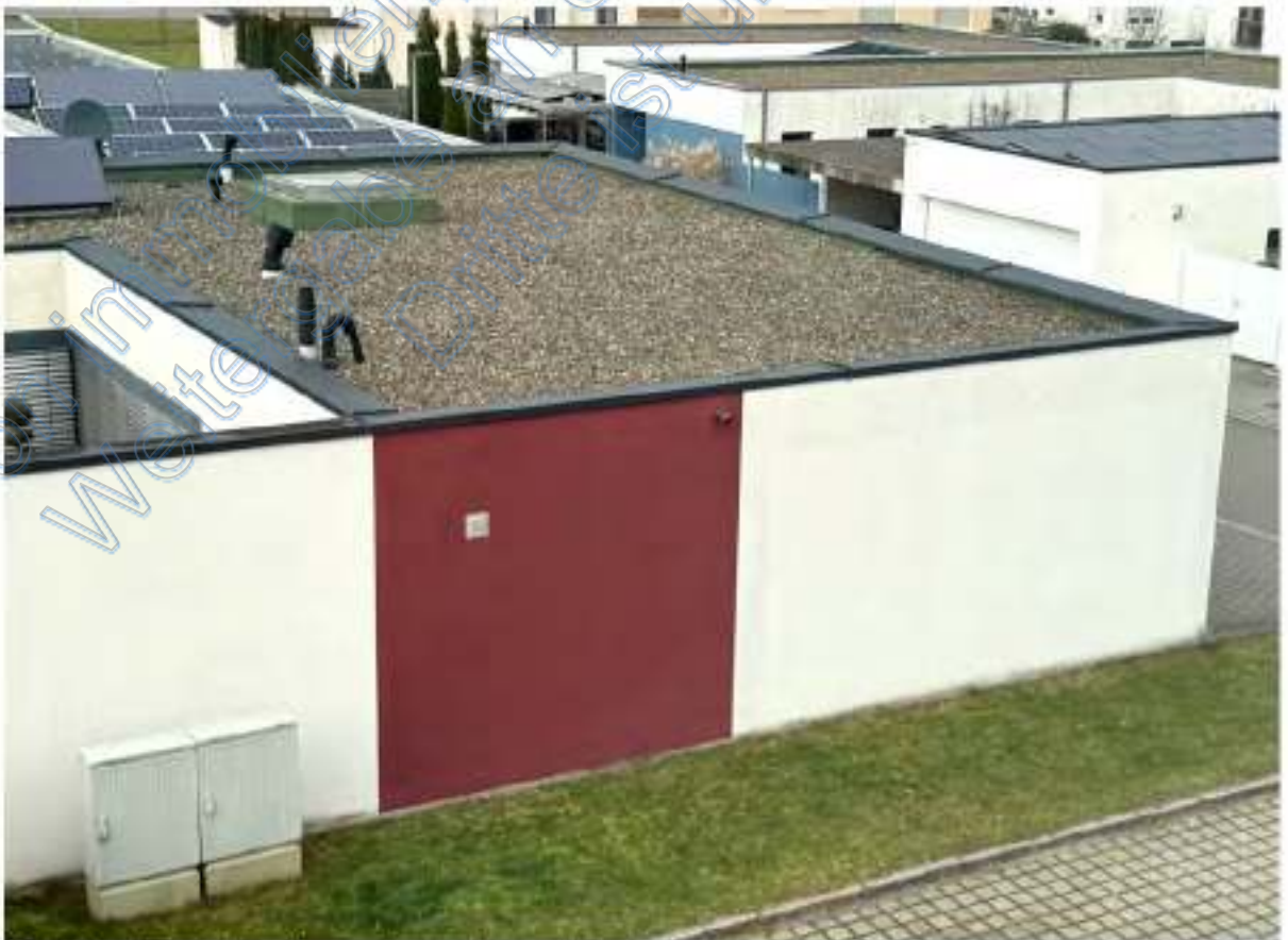
Ostlicher Bereich Reihenendbungalow mit Dachaufsicht und Lichthof von Süden
