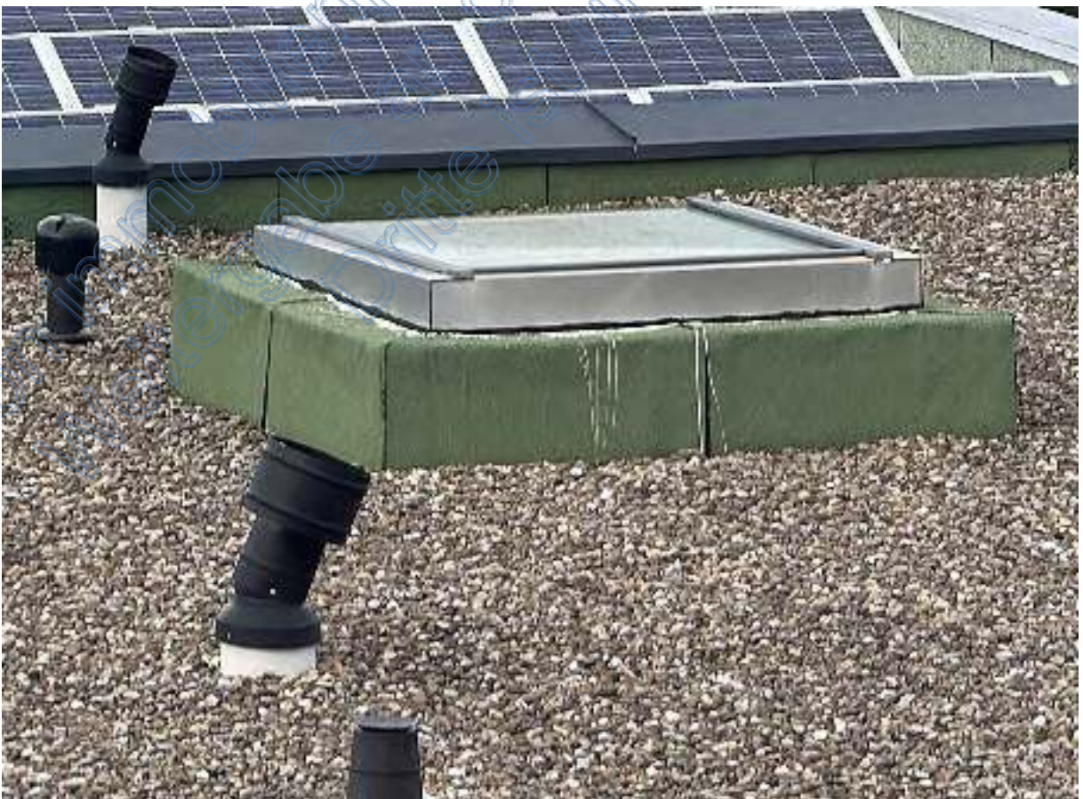
Entlüftungsrohre und Flachdachfenster über dem Wohn/Esszimmer
