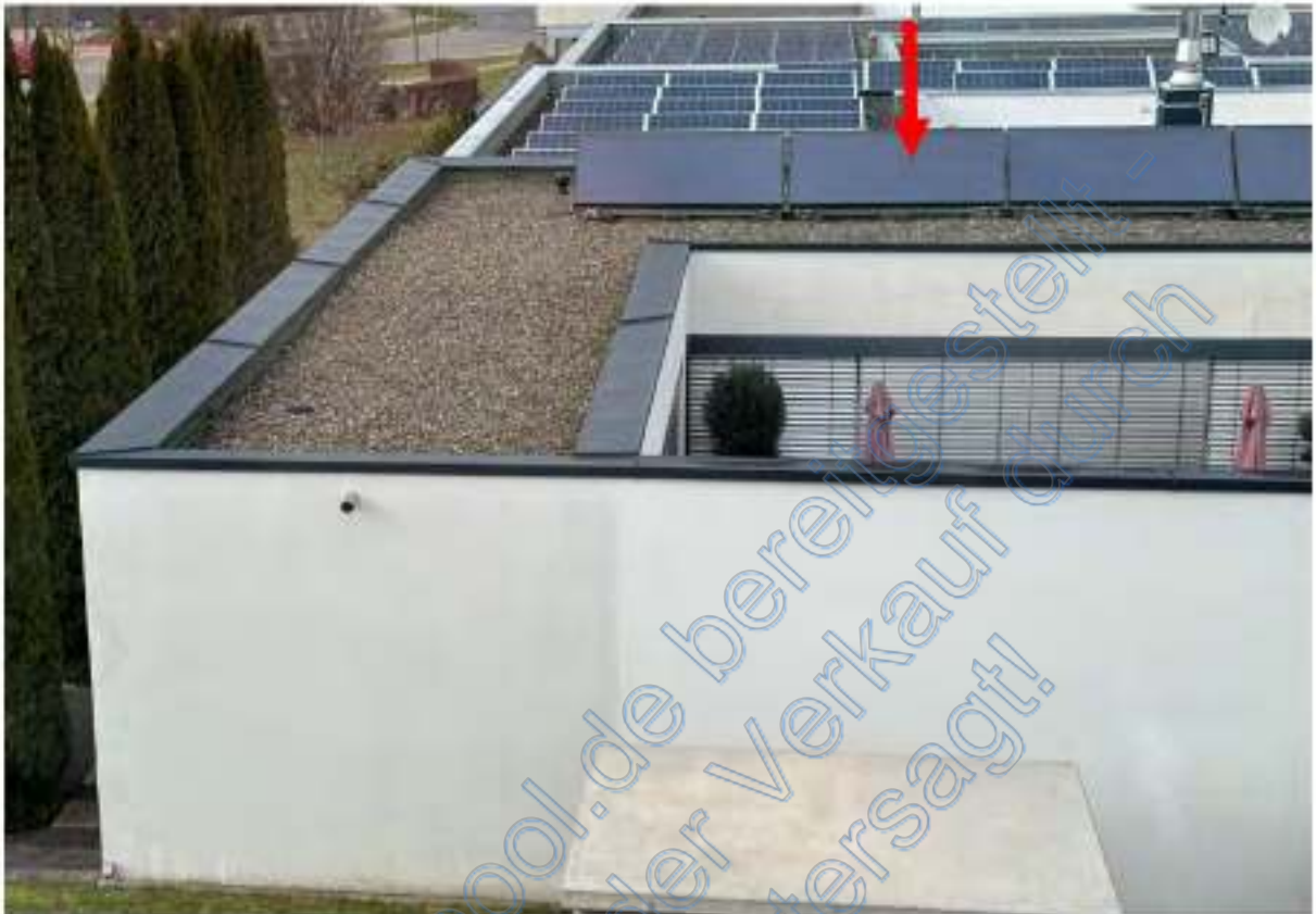
Westlicher Bereich Bungalow mit Dachaufsicht und Lichthof von Süden, Pfeil Solarplatten
