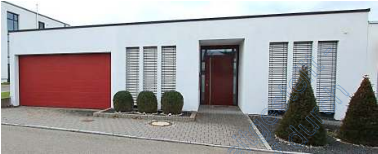
Ostansicht Bungalow mit integrierter Doppelgarage und Haustür
