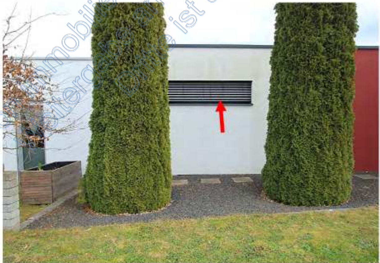
Nordwestlicher Außenbereich, Pfeil Badfenster (Oberlicht)
