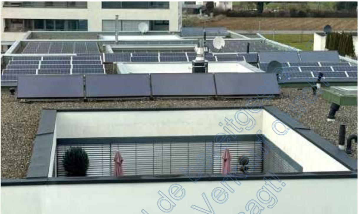
Lichthof und Solarplatten auf dem Dach von Süden
