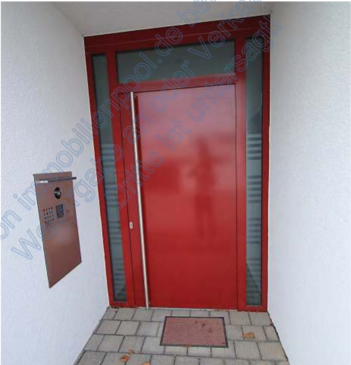
Haustür, links in die Wand eingefasster Briefkasten mit Klingelanlage
