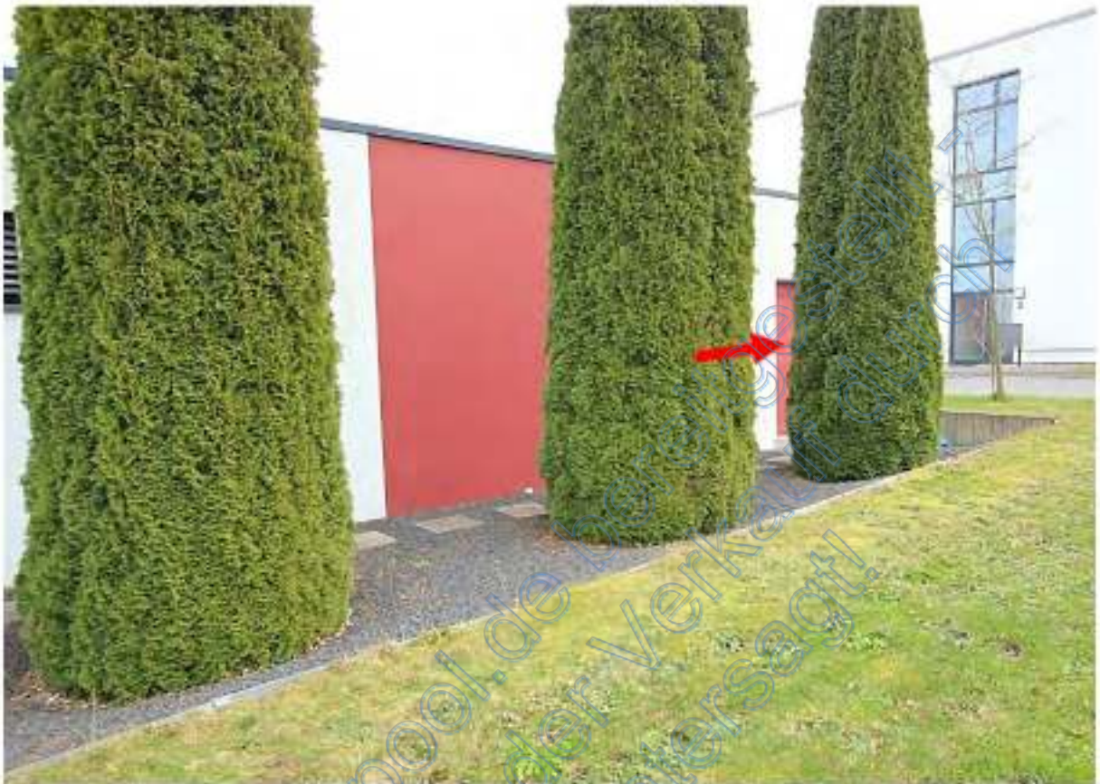
Südwestlicher Außenbereich mit Westseite Bungalow, Pfeil Tür zum Abstellraum
