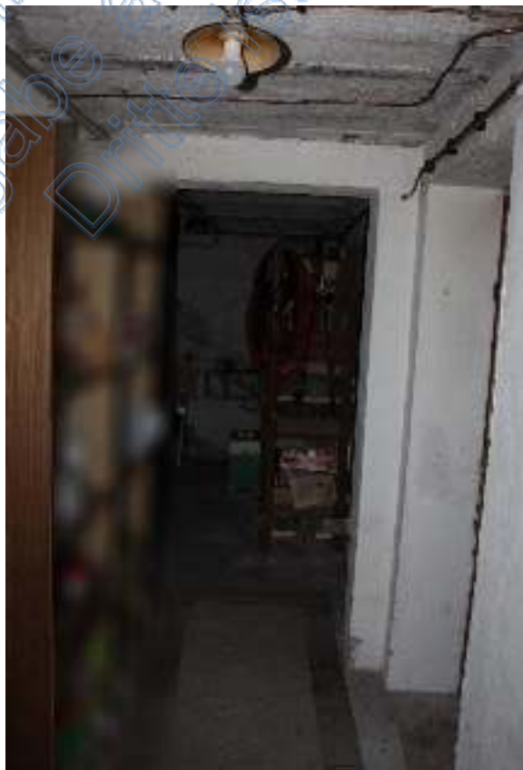
Foto 13: Blick in das KG des Wohnhauses
