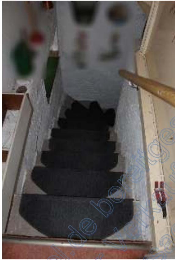
Foto 16: steile und schmale Treppe vom EG zum KG
