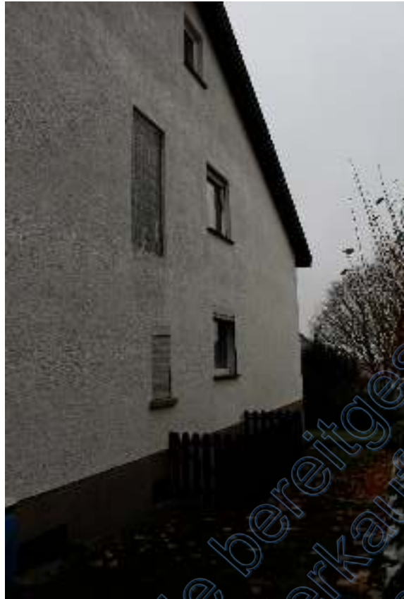
Foto 6: Blick auf die Giebelseite vom Hof aus (Nordseite)
