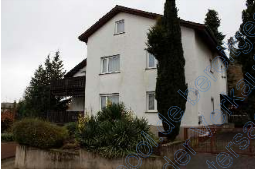
Foto 1: Ansicht des Wohnhauses von der Straße Stephansbergweg aus
