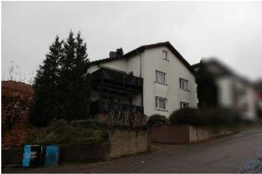
Foto 3: Ansicht des Wohnhauses von der Ecke Weinheimer Straße/ Stephansbergweg aus
