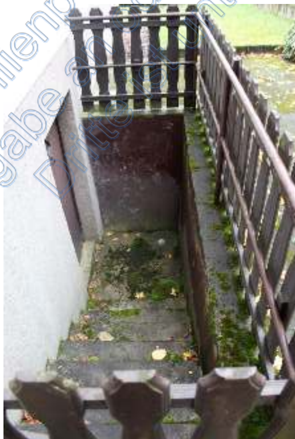
Foto 10: Blick auf die Außentreppe zum KG des Wohnhauses
