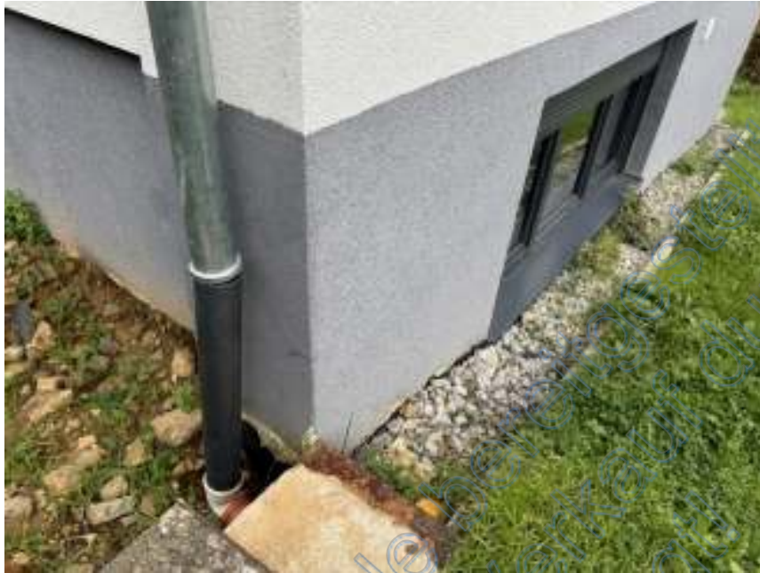
Bild 11: Südwestliche Gebäudeecke mit Blick auf die Wohnung im UG
