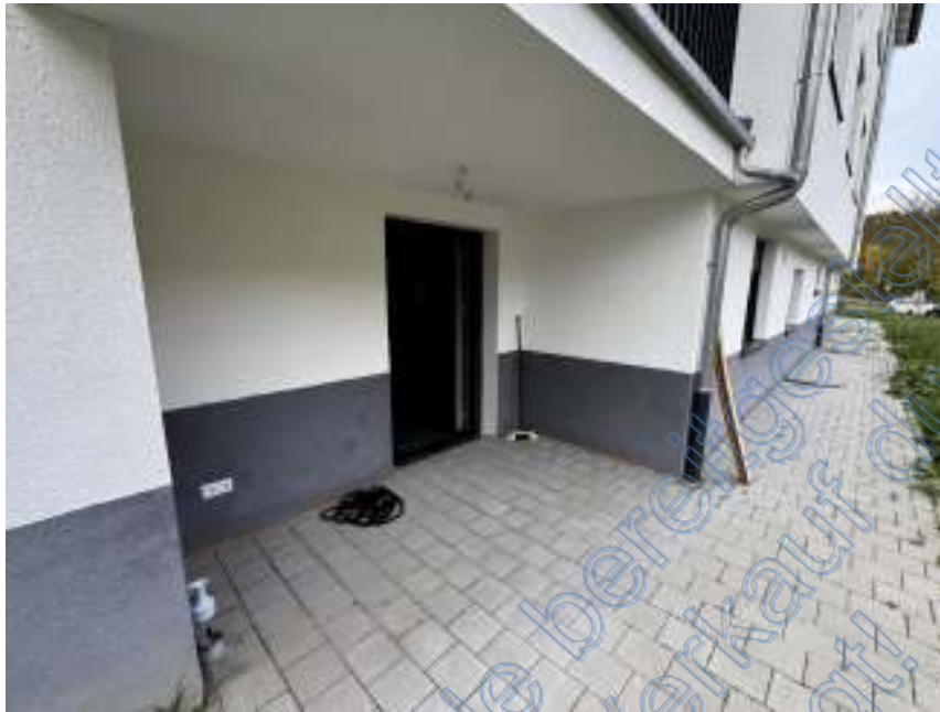
Bild 9: Fenstertür der Wohnung im UG an der Gebäude-Ostseite
