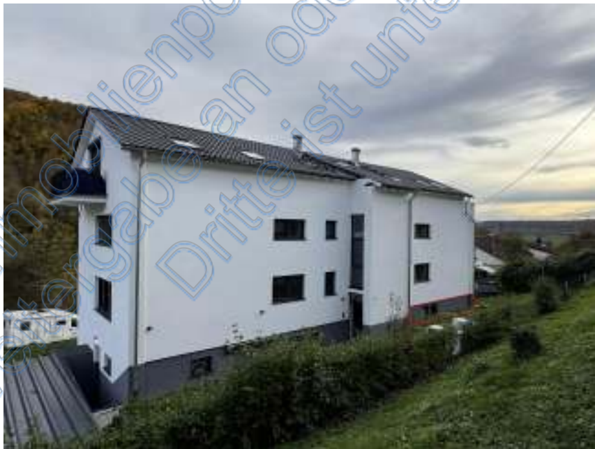
Bild 2: Gebäudeansicht von Norden mit rot markiertem Bewertungsobjekt
