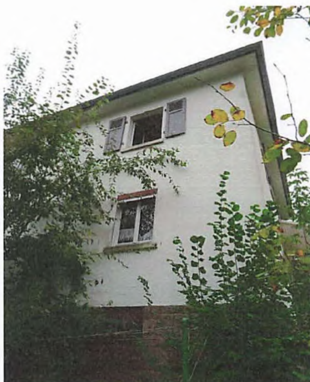
Foto 6: Ansicht von der Gartenseite aus
