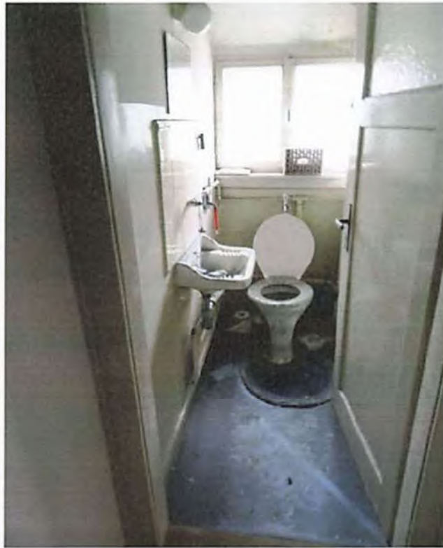
Foto 21: WC im DG
