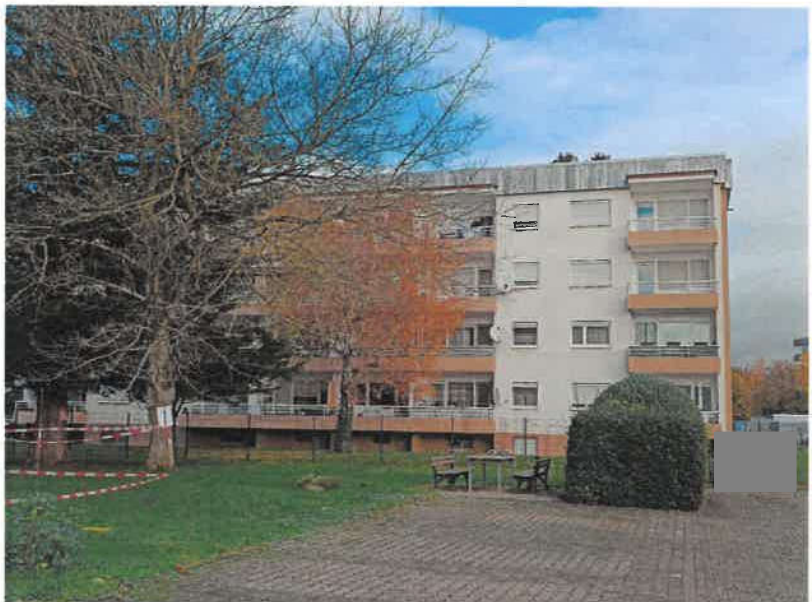
Ansicht des Doppel- hauses Heidelberger Straße 8-10, von Süden
