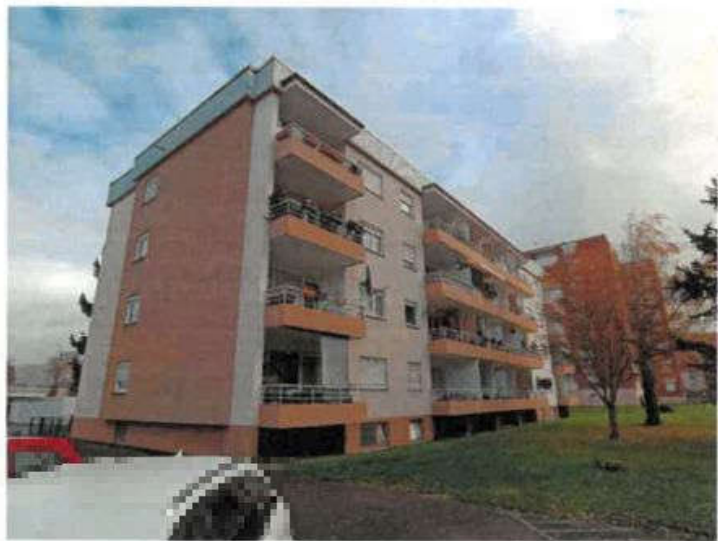
Ansicht von Süd- westen (im Vorder- grund Heidelberger Straße 10)
