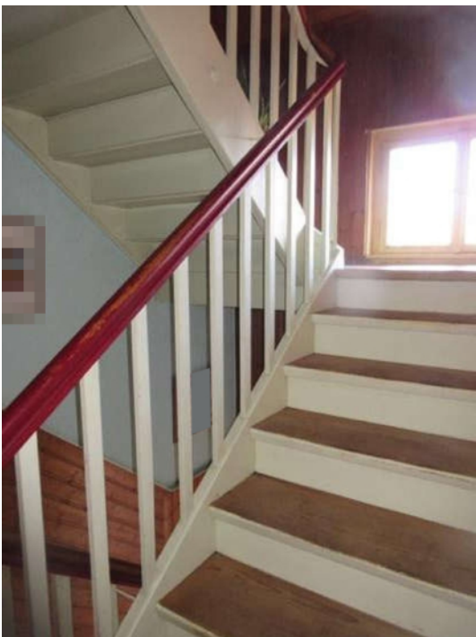
Treppe zum DG
