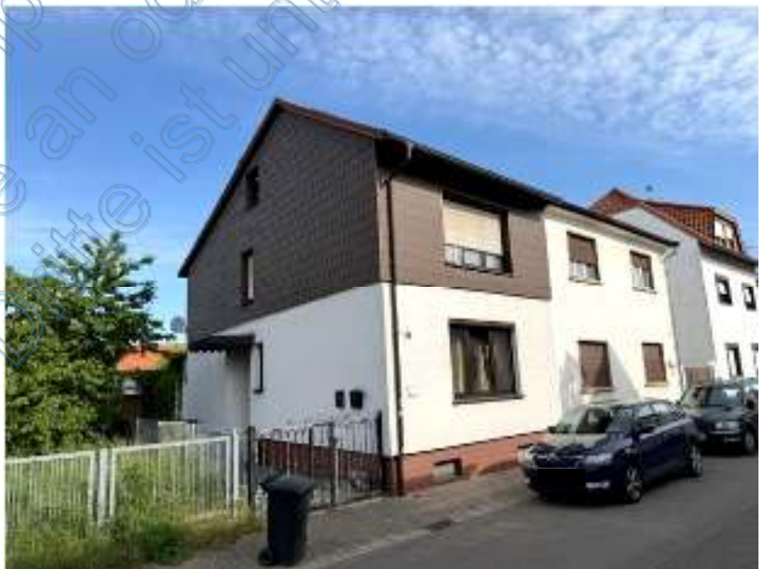
Foto 2 des SV: Ansicht von Südosten
