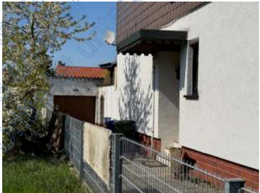
Foto 4 des SV: Hauseingang, Zugang /Zufahrt zur Garage
