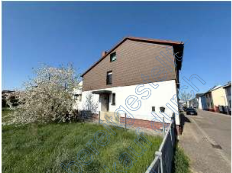
Foto 3 des SV: Ansicht von Süden, Hauseingangsseite
