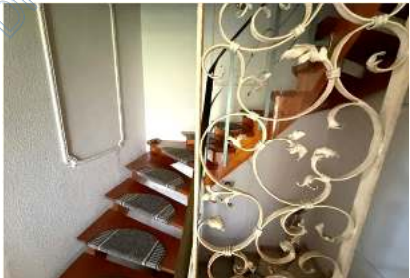
Foto 10 des SV: Geschosstreppe (EG bis DG)
