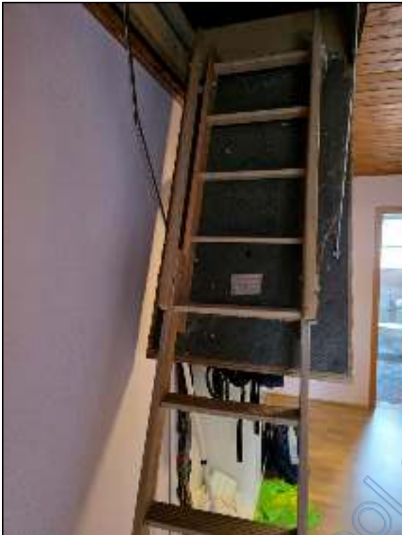
Treppe zum Spitzboden
