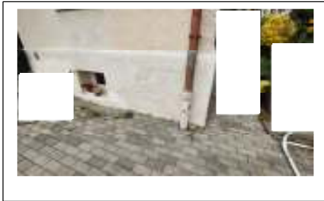
d) Schäden Fallrohre
