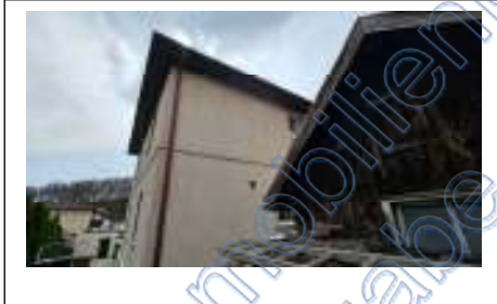
g) Rep.-Stau (Anstrich) Fassade
