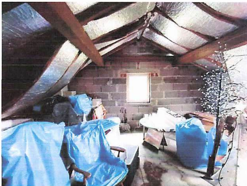
Aufnahme 12: nicht ausgebautes Dachgeschoss
