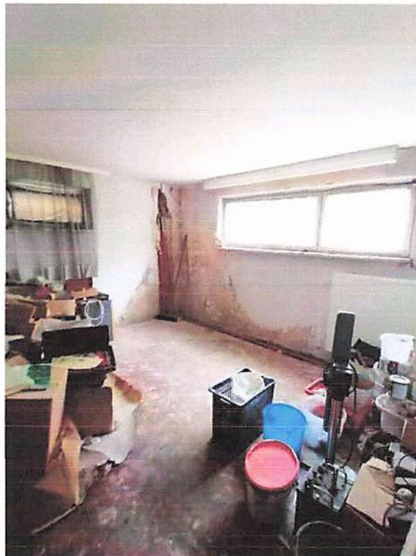
Aufnahme 16: Beispiel Kellerraum
