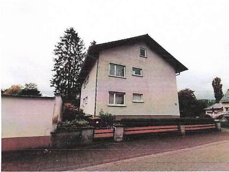
Aufnahme 1: Straßenansicht Nordost
