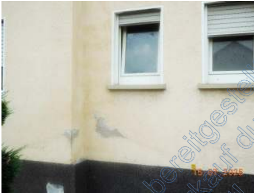
Bild 3: Feuchtigkeitsschäden (straßenseitig)
