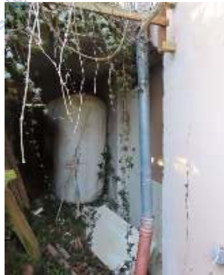
Bild 32: UG Teilfassade Süd mit neu geplanten 2. Zugang ins Gebäude
