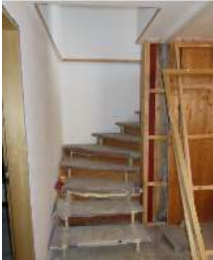
Bild 13: Treppe UG zu EG
