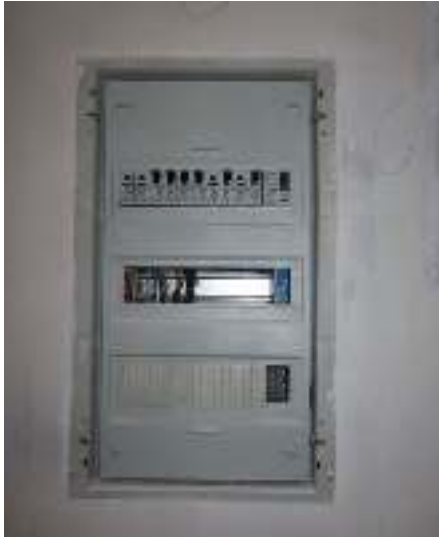
Bild 21: Elektro Unterverteiler
