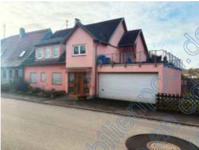
(8) Ansicht Nord – Ost von der Hauptstraße
