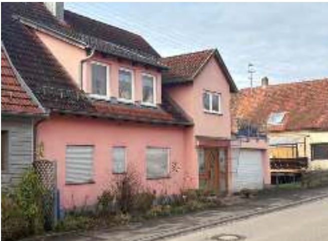
(6) Ansicht Nord – Ost von der Hauptstraße
