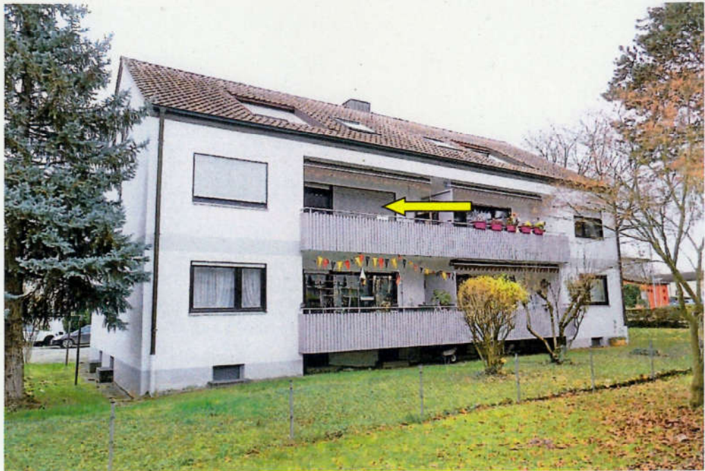
Blick auf das Haus von Nordwesten aus. Der gelbe Pfeil zeigt auf das Wohnzimmerfenster mit Zugang zum Balkon. Links daneben befindet sich das Fenster des Schlafzimmers.
