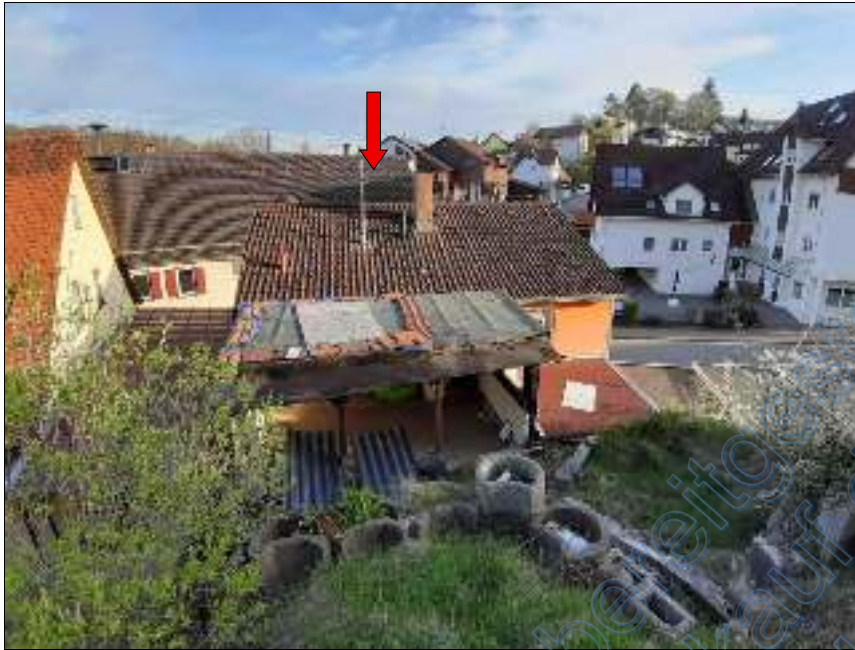
Ansicht vom oberen Grundstücksbereich
