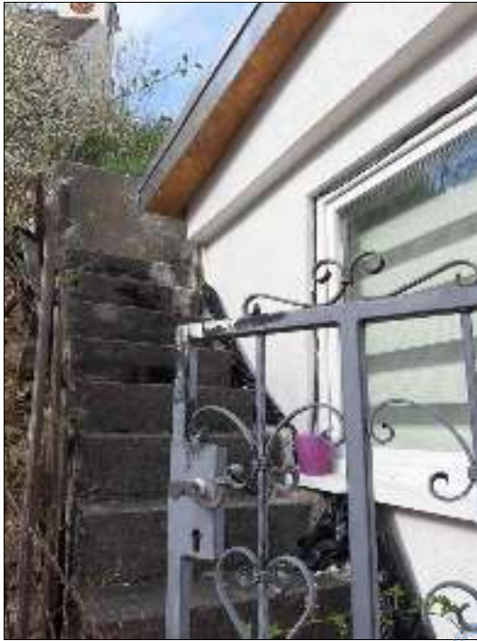
Ansicht von Westen Zugang über eine Außentreppe (teilweise außerhalb des Grundstücks)
