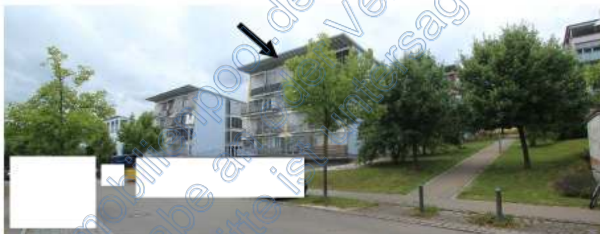
Eigentumsanlage Virchowstraße 26 - 32 von Südosten, Pfeil Hausnummer 26
