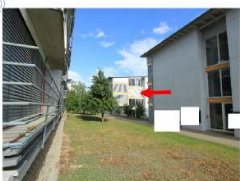
Blick von Westen, roter Pfeil Wohnung 3.17, rechts Haus 4
