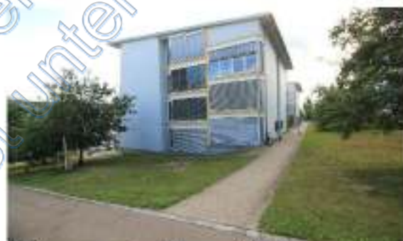
Fußweg zu den Häusern 3 + 4
