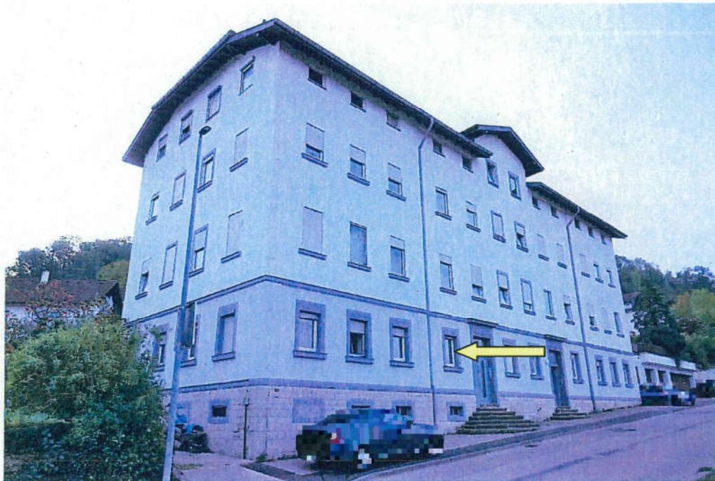
Blick auf das Wohnhaus auf dem Flst. Nr. 1008/1 von Nordwesten aus. Der gelbe Pfeil zeigt auf das Fenster eines der Kinderzimmer der zu bewertenden Wohnung Nr. 1. Links daneben befinden sich die beiden Fenster des Schlafzimmers sowie das Fenster des zweiten Kinderzimmers.
