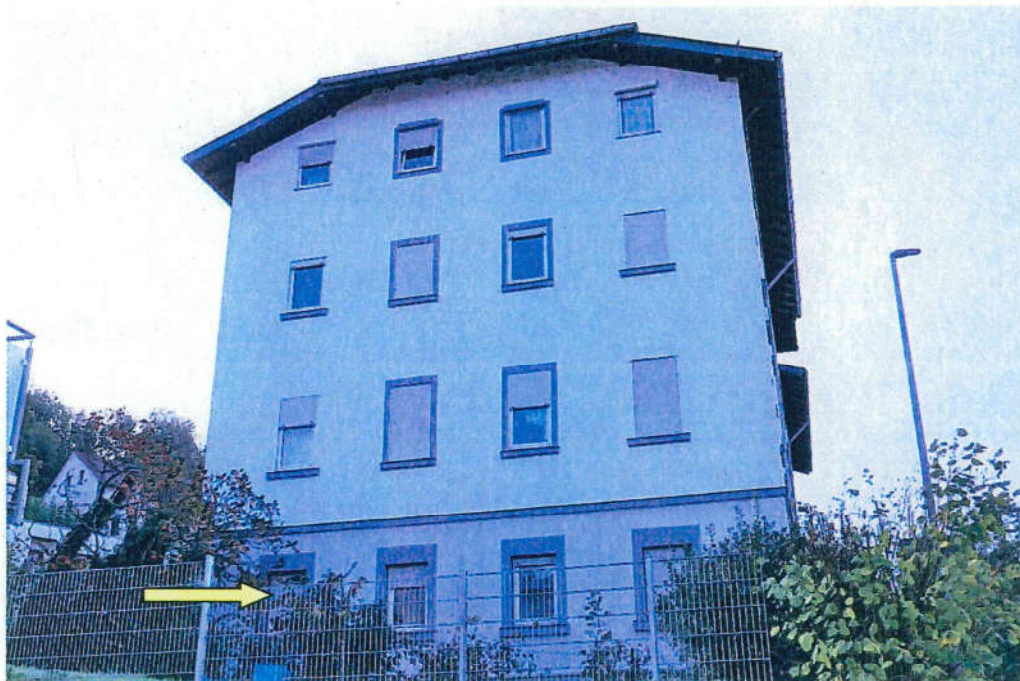
Blick auf das Wohnhaus von Norden. Der gelbe Pfeil zeigt auf die beiden Fenster des Schlafzimmers. Rechts daneben befinden sich die beiden Fenster eines der Kinderzimmer.
