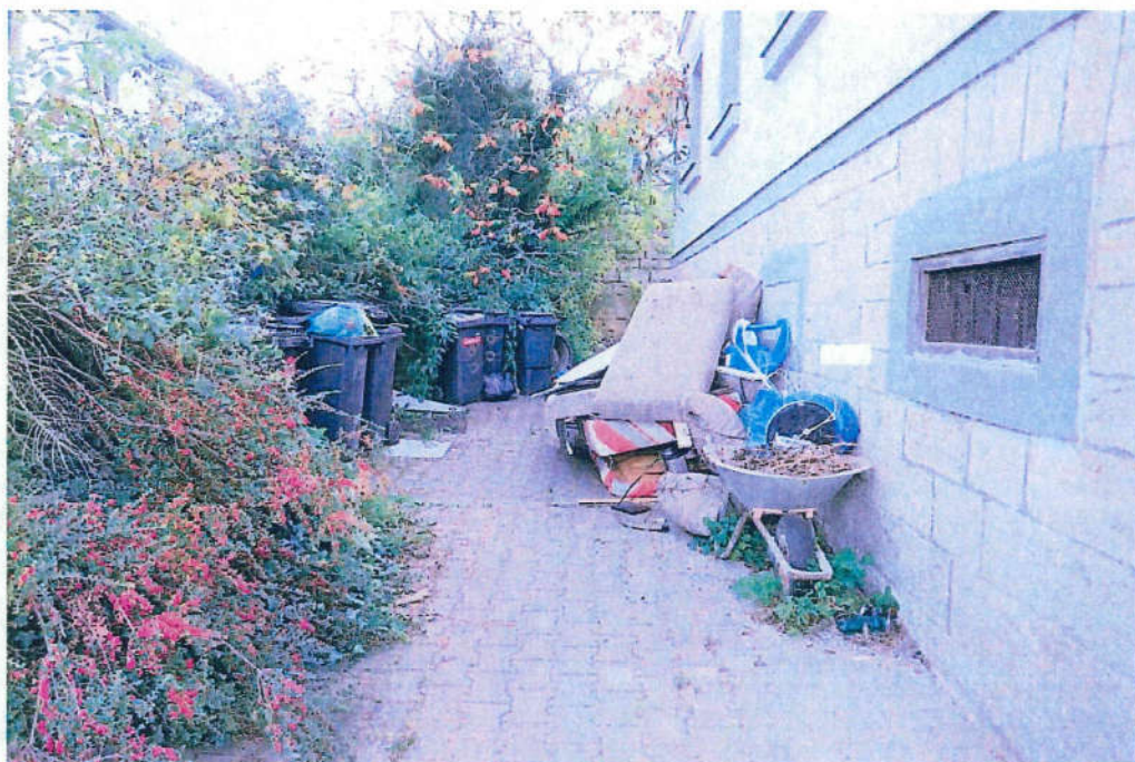
Sicht auf die Zuwegung zum rückwärtigen Bereich von Westen. Dort befinden sich die Mülltonnen. Ferner wird in diesem Bereich auf Unrat gelagert.
