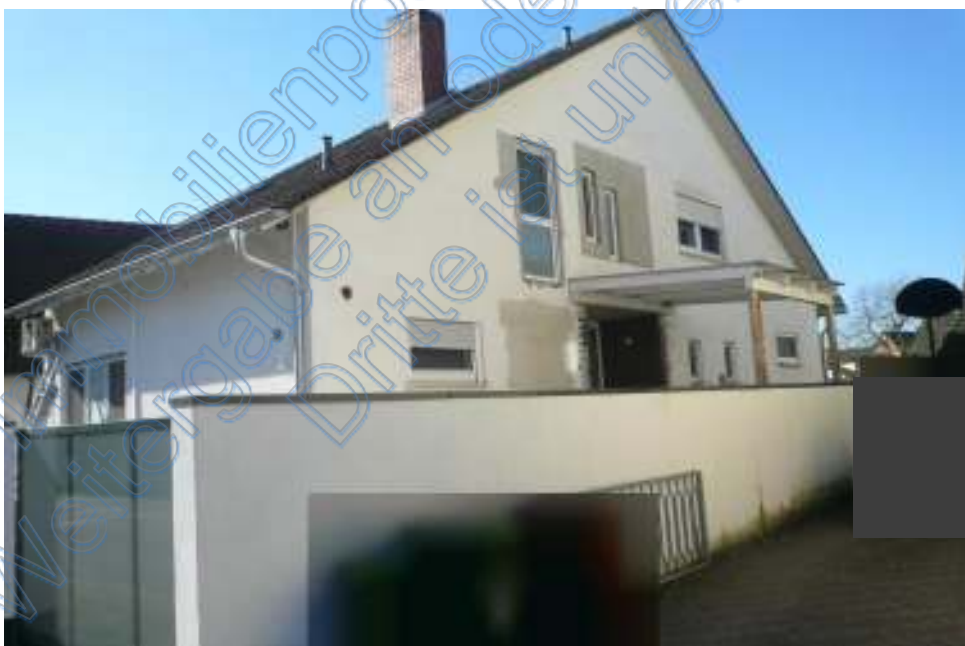
Abb. 2: Straßenansicht aus nordöstlicher Richtung
