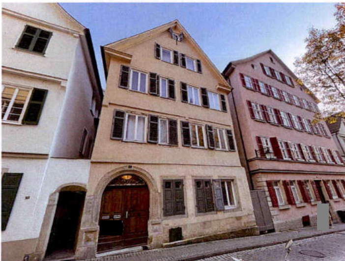
Ansicht Nord von der Neckarhalde
