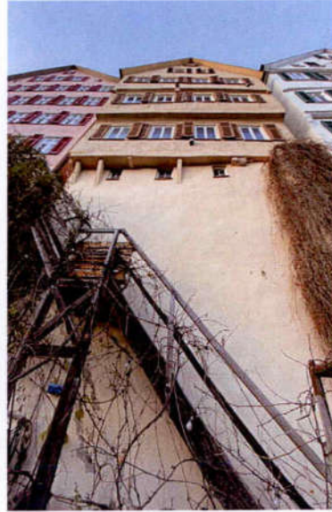
Ansicht Süd mit Außentreppe
