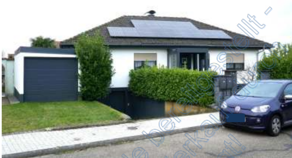
Blick von Norden auf das zu bewertende Einfamilienwohnhaus mit Fertiggarage (links).
