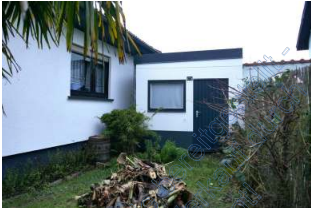
Rückansicht der Fertiggarage von Süden.
