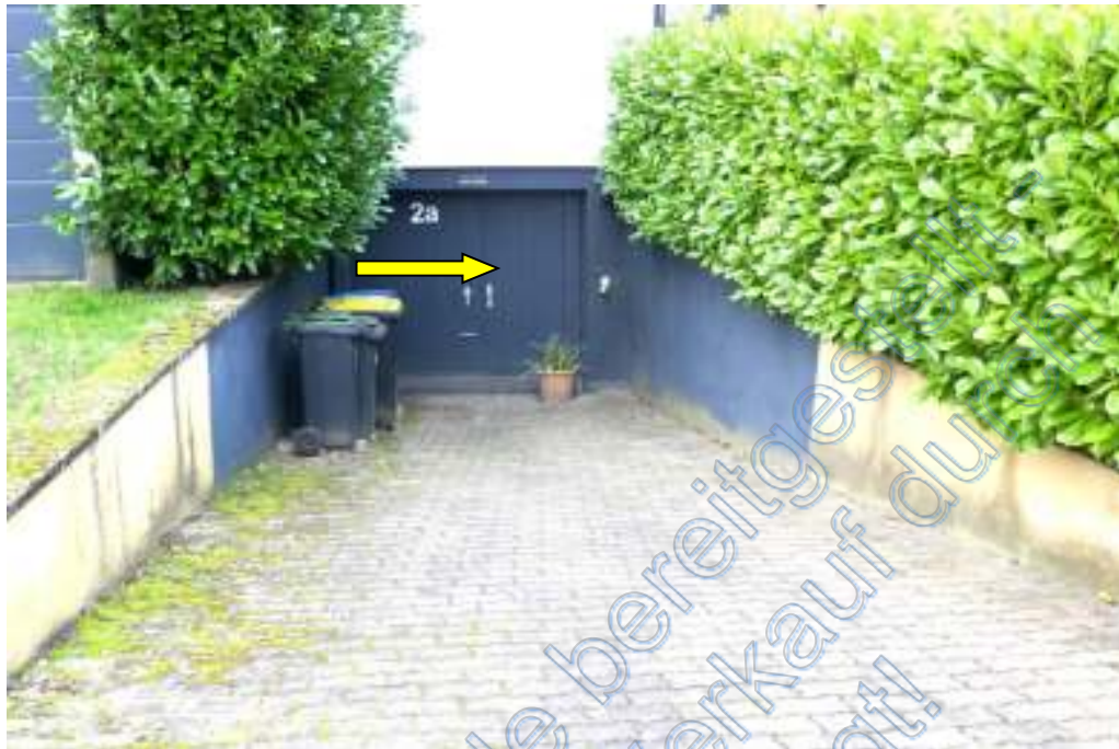
Sicht auf die ehemalige Zufahrt zur Garage im Untergeschoss. Der gelbe Pfeil zeigt auf den separaten Zugang zum Einliegerwohnung im Untergeschoss.
