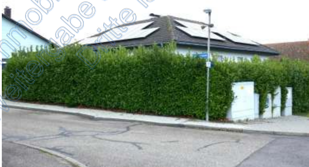
Ansicht des Wohnhauses von Nordwesten. Auf dem Dach befindet sich eine Photovoltaikanlage.
