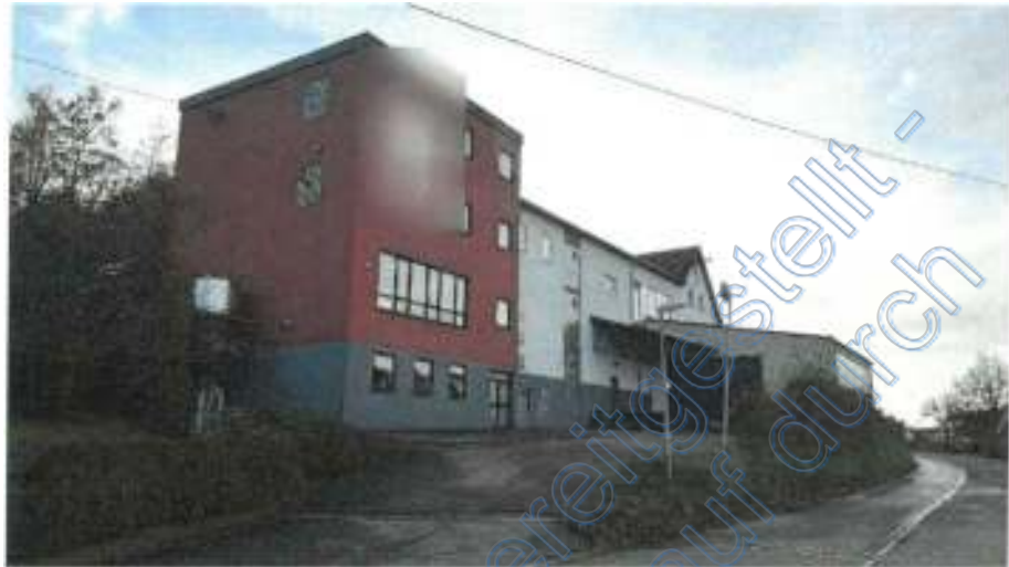
Zufahrt, Nord- und Ostseite
