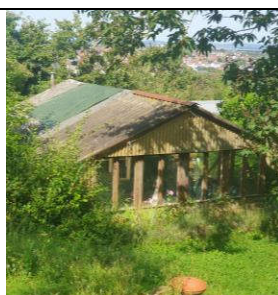
Ansicht Süd Holzhaus mit Anbau
