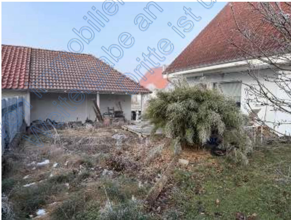
Terrasse und Gartenbereich, überdachter Abstellplatz hinter den Garagen
