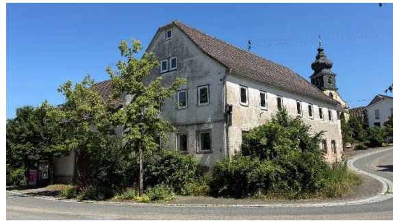
Hauptgebäude: Ansicht von Norden
