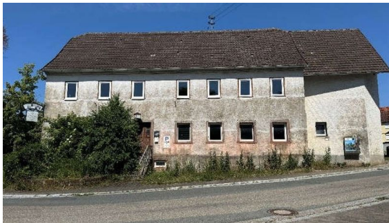
Hauptgebäude: Ansicht von Westen
