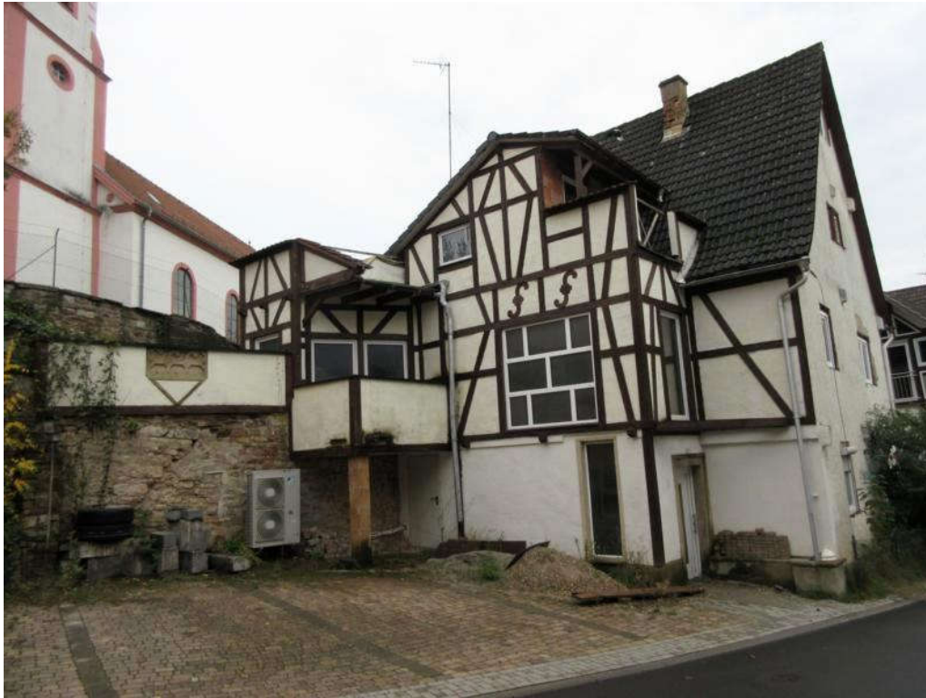
Nordwestansicht Wohnhaus Kirchgraben 5
