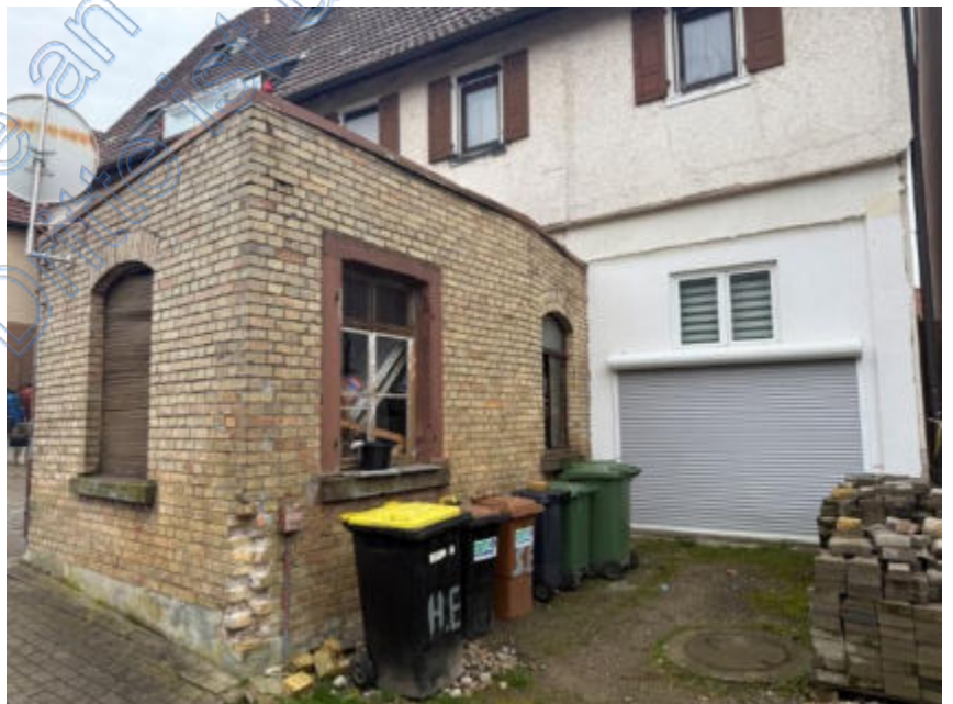
Foto 6 des SV: Ansicht von Nordwesten, im Vordergrund Nebengebäude (ehem. Schlächterei mit Laden)
