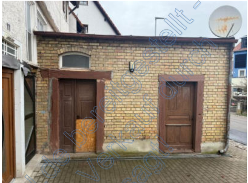
Foto 5 des SV: Ansicht von Osten, Nebengebäude (ehem. Schlächterei mit Laden)
