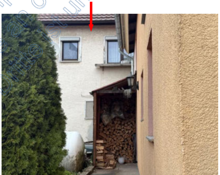
Foto 4 des SV: Ansicht von Süden; von der Machtolfstraße; Detail Ge- bäuderückseite; Roteintragung (Pfeil) durch den SV
