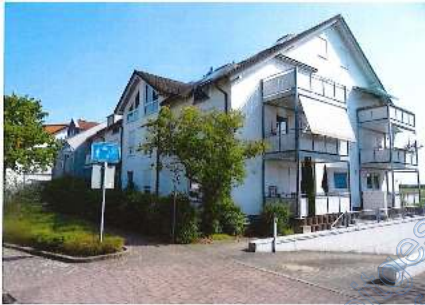
Foto 3: Ansicht des Wohnhauses mit Tiefgaranzufahrt
