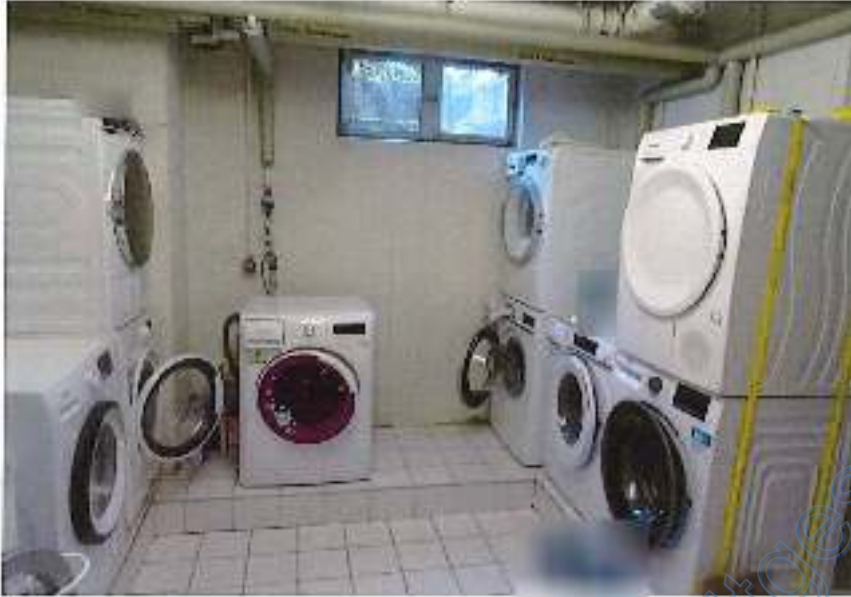
Foto 8: Waschküche im UG
