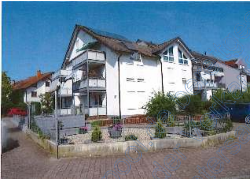
Foto 1: Ansicht des Mehrfamilienhauses
