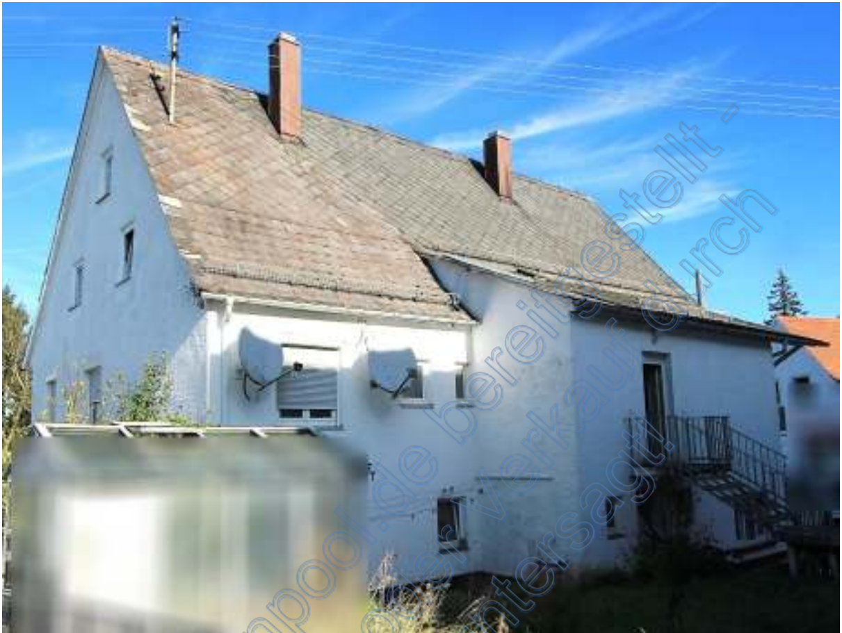
Wohnhaus von Südwesten
