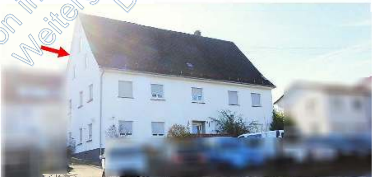
Wohnhaus von Nordosten
