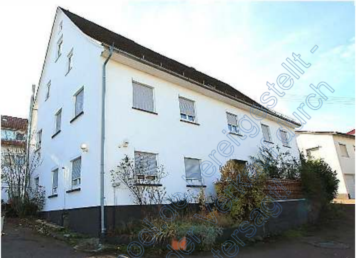
Wohnhaus von Nordosten
