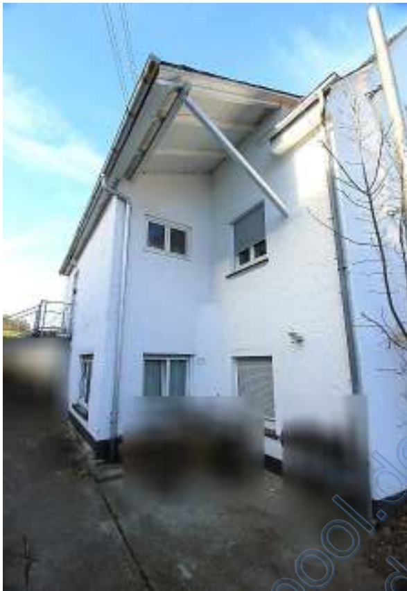
Wohnhaus mit Hof von Südosten
