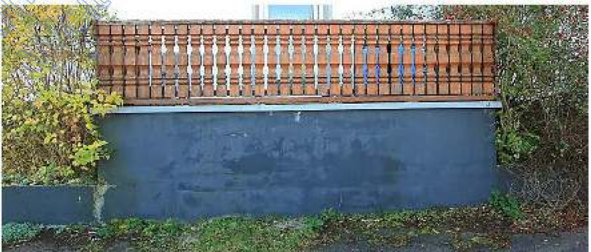
Balkonterrasse mit Holzgeländer im Norden
