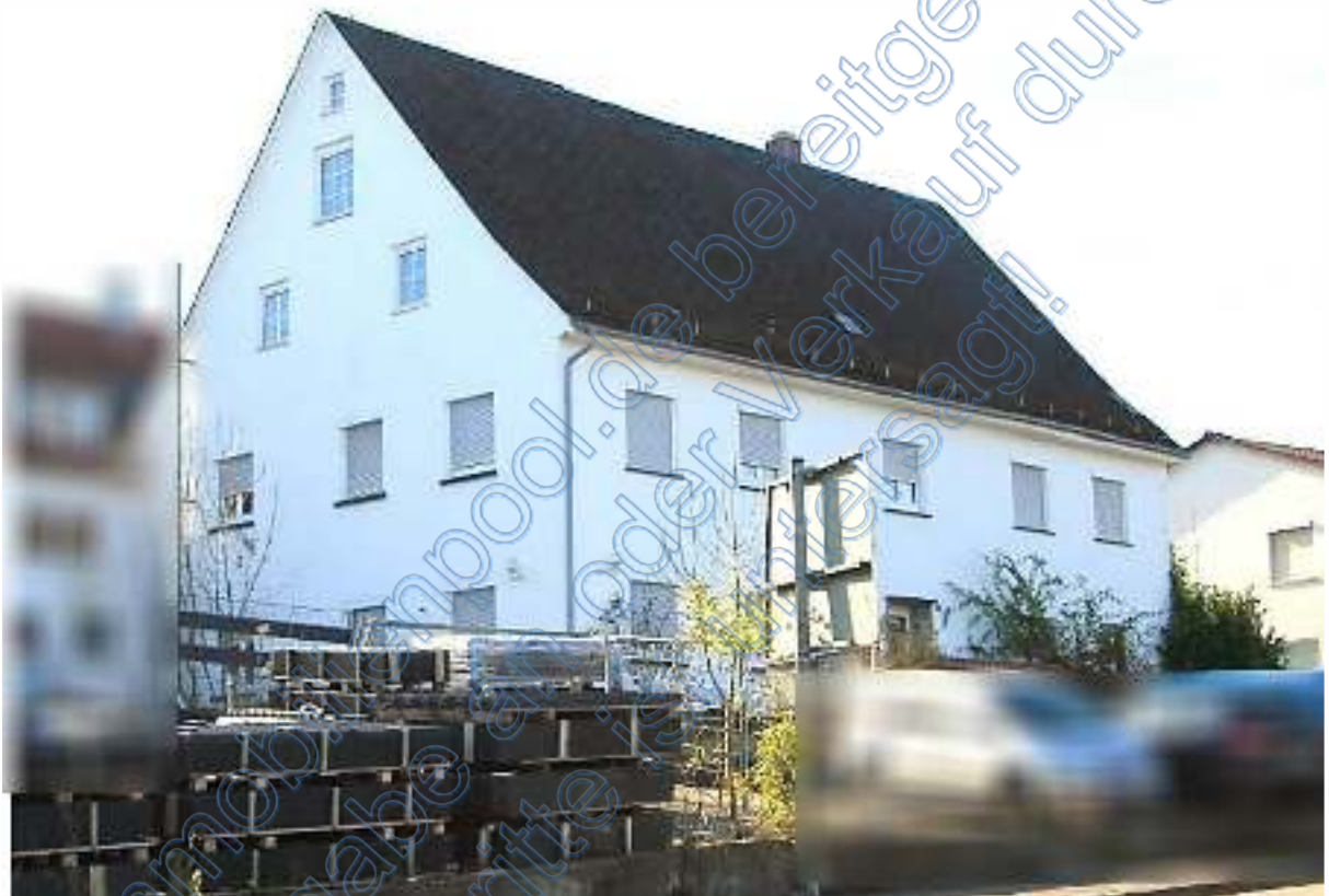
Wohnhaus von Nordosten
