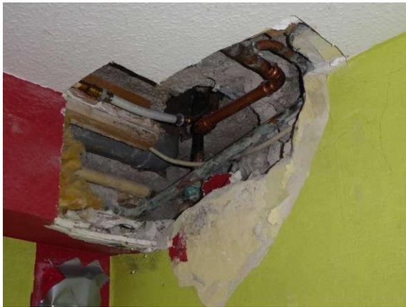
19. Aufgerissene Decke nach Wasserschaden
