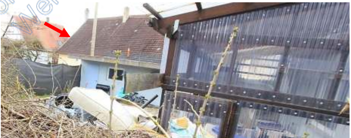
Blick von Norden zum südöstlichen Garten, vorne rechts Umhausung Terrasse, Pfeile Garage
