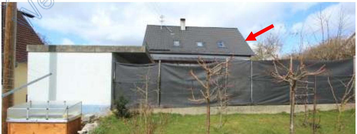
Grundstück von hinten bzw. von Südosten mit Sichtschutzplane, Pfeil Wohnhaus, links Garage
