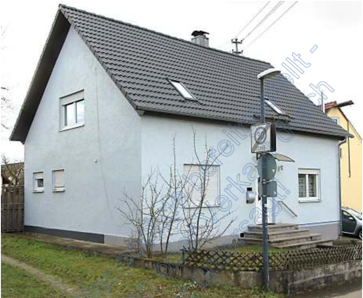
Wohnhaus von Norden mit Elektrokabel an der Fassade
