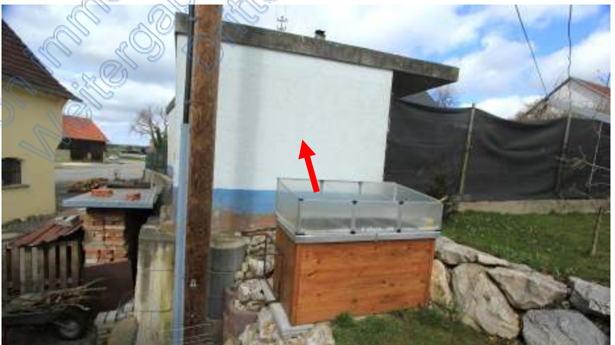
Südostseite Garage, rechts davon Sichtschutzplane vom Garten
