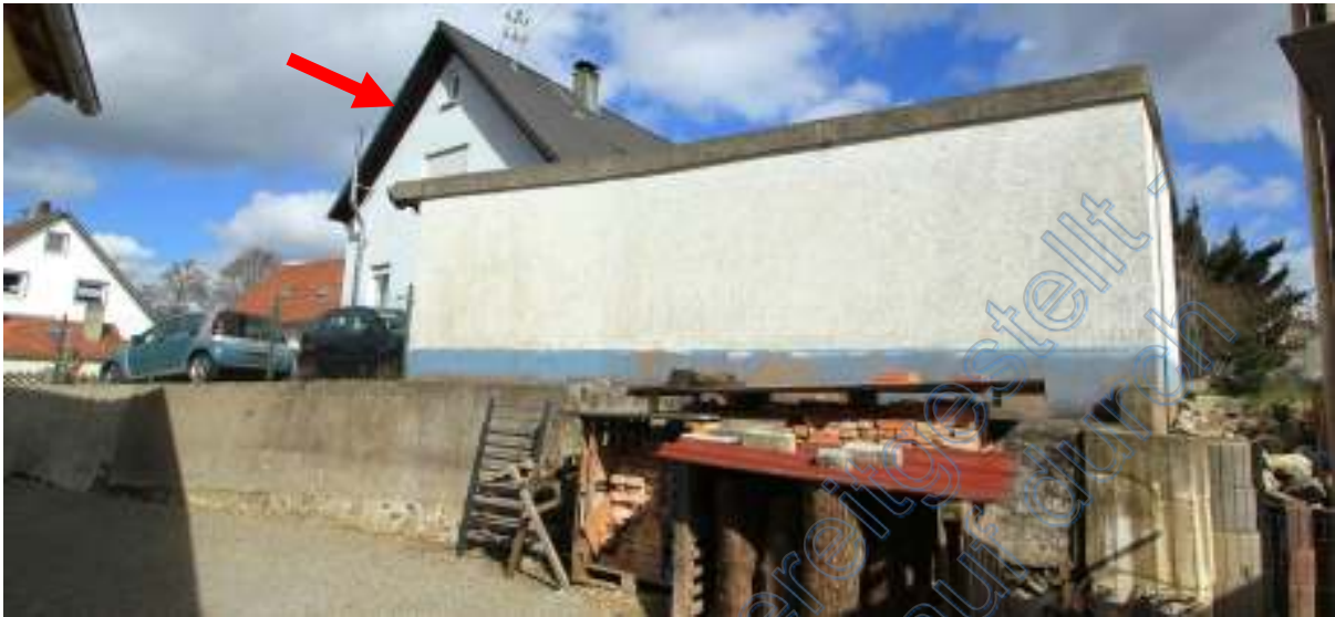
Grundstück mit Garage von Süden, Pfeil Wohnhaus
