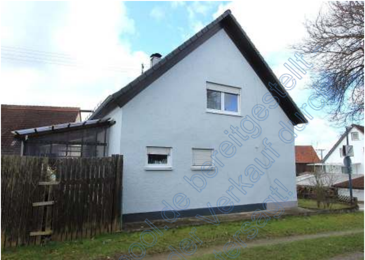
Nordostseite Wohnhaus mit umhauster Terrasse
