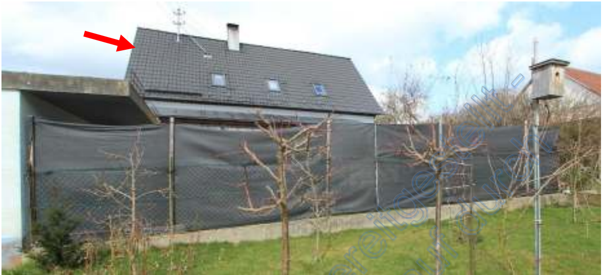
Grundstück von Südosten mit Sichtschutzplane, Pfeil Wohnhaus, links Garage mit Seitendach
