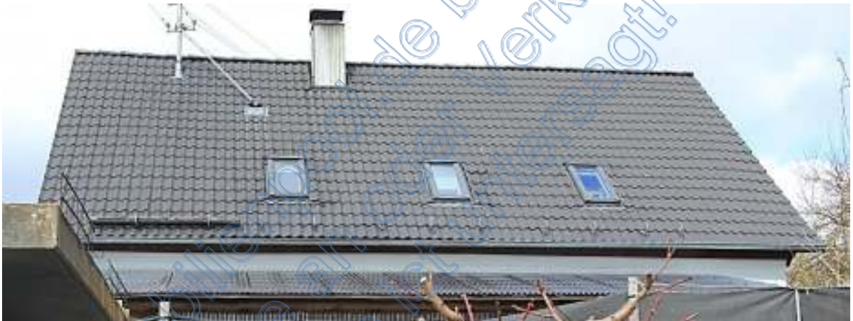
Südostdach Wohnhaus mit 3 Wohndachflächenfenstern
