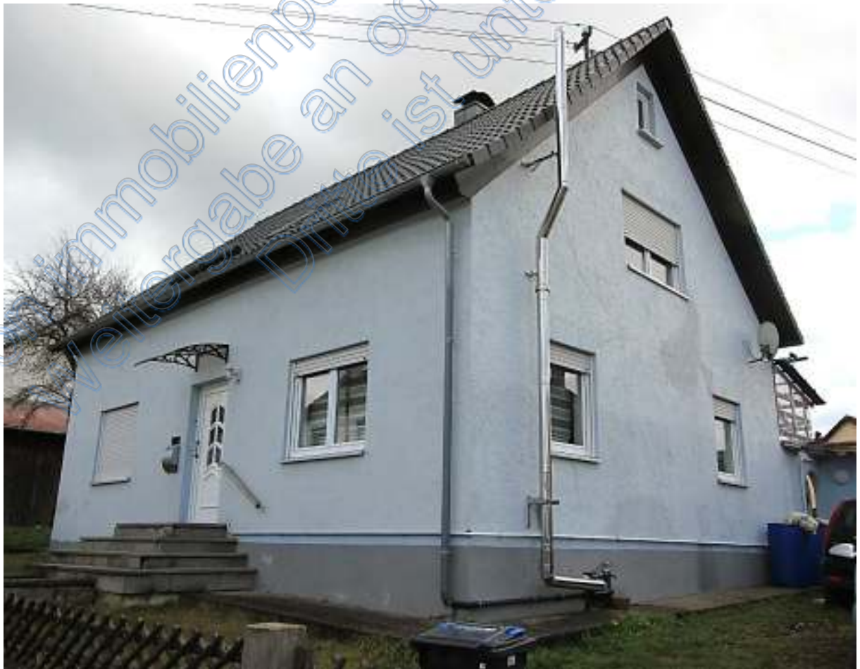
Wohnhaus von Westen mit Edelstahlschornstein
