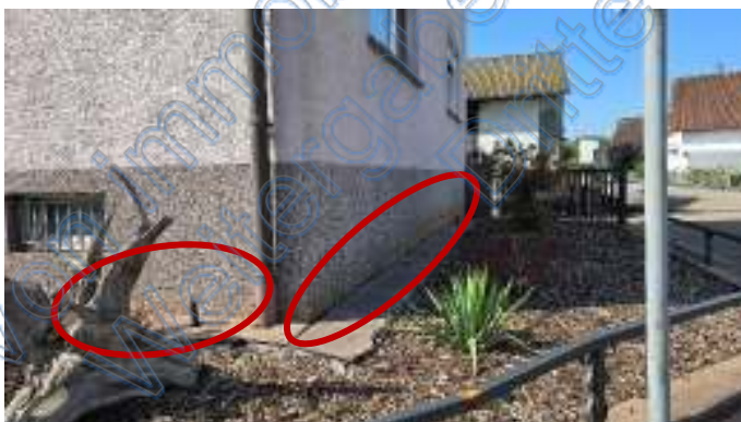
beschädigter Sockelputz
