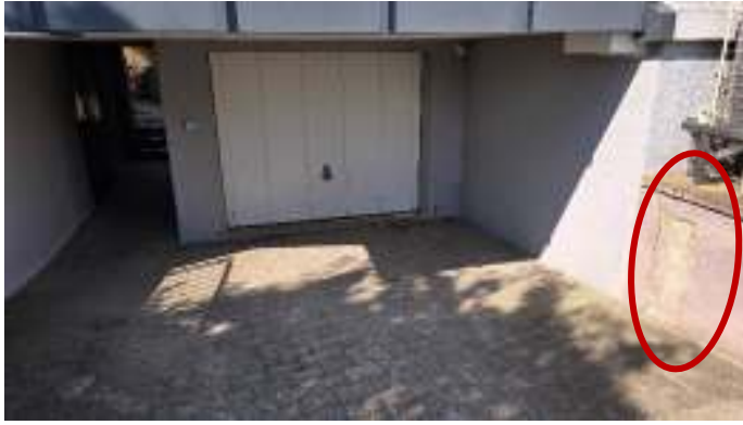
Sockelputz an der Garagenabfahrt
