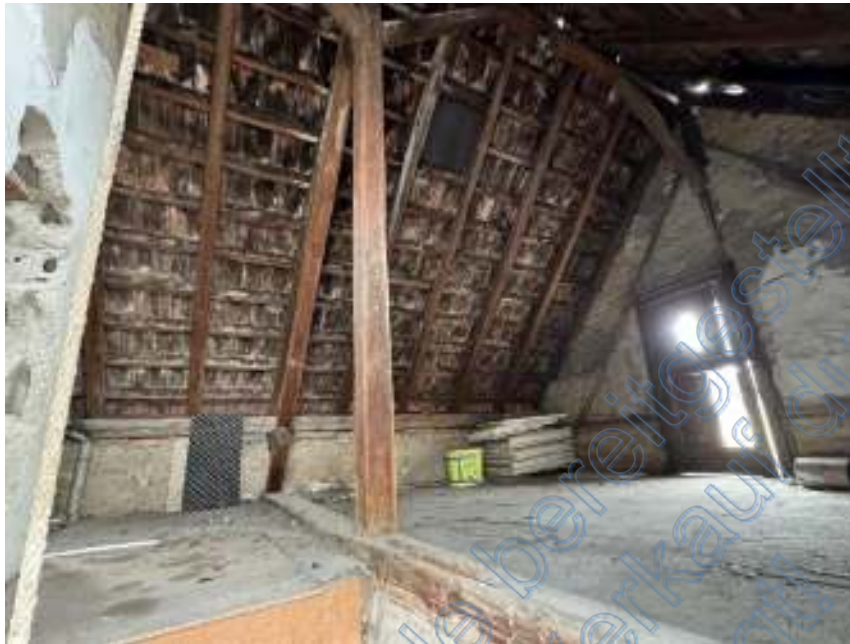
Bild 11: Dachboden des nordwestlichen Gebäudeteils (Friedrichstr.)
