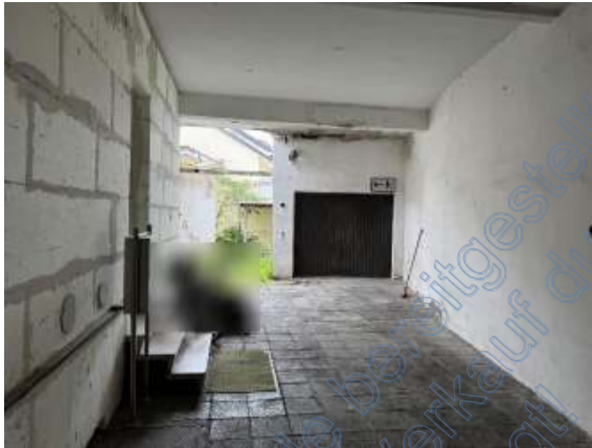
Bild 5: Innenhof / Durchfahrt mit Zugang zu den Wohnungen und Blick nach Nordwesten
