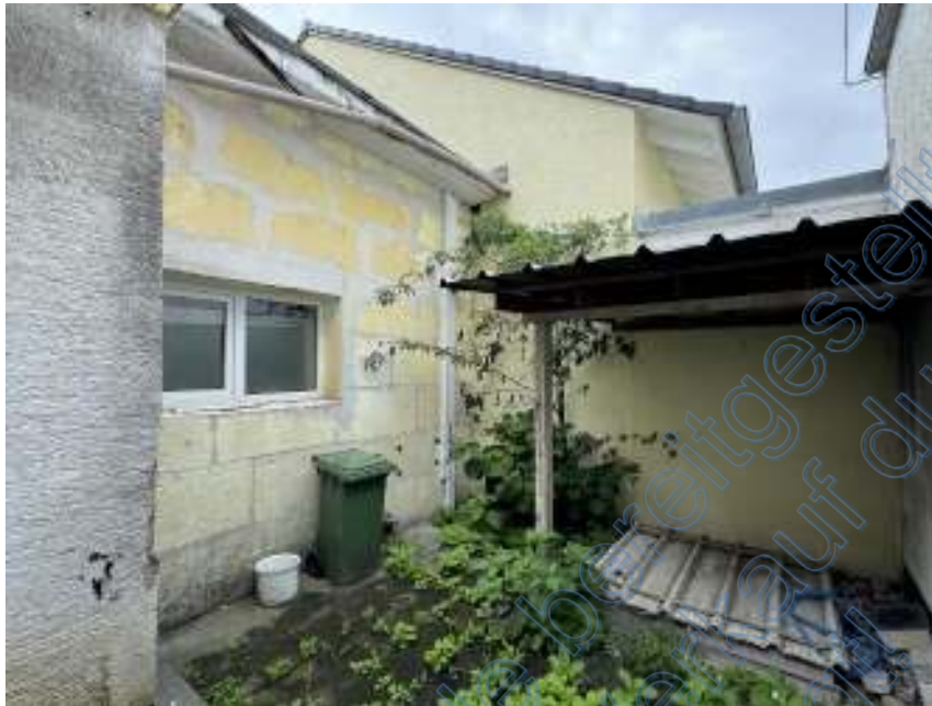
Bild 9: Innenhof (Gebäuderückseite) mit Unterstand
