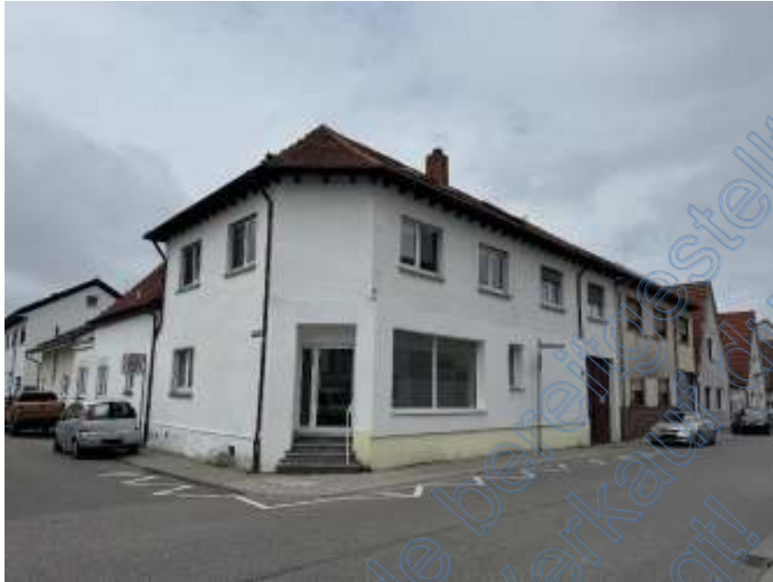
Bild 1: Gebäudeansicht von Süden (Hauptstraße/Friedrichstraße)
