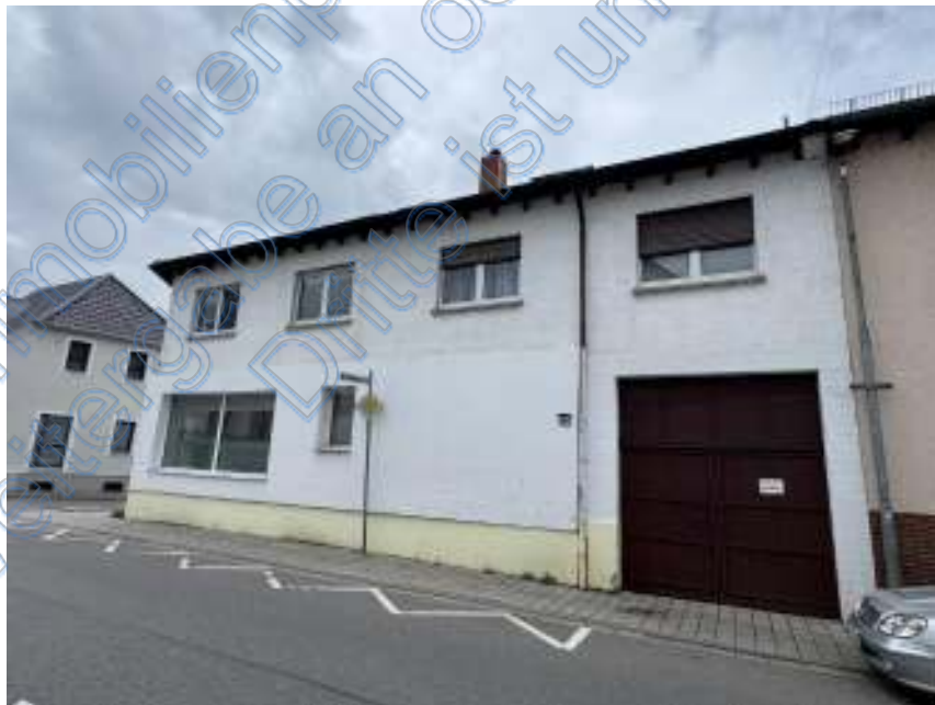
Bild 2: Gebäudeansicht von Osten (Hauptstraße)
