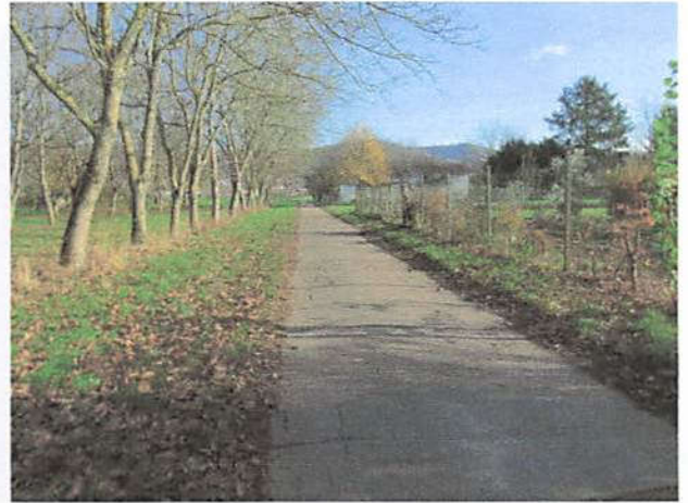
Weg Nordseite, Blick in östliche Richtung
