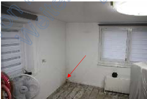
Zimmer im OG mit Feuchteschaden
