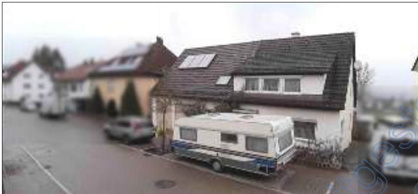
Ansicht Lindlestraße, Südseite
