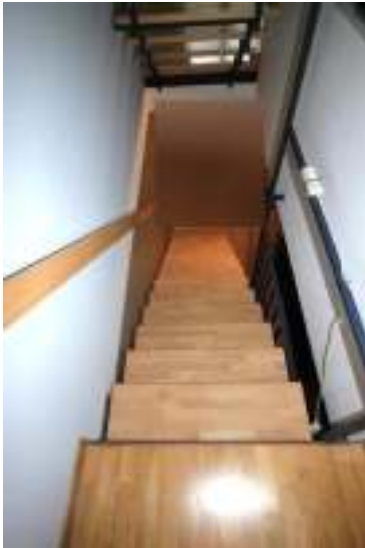
Kellertreppe von oben
