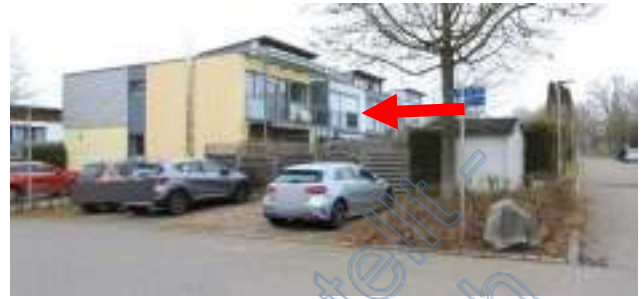
Reihenhausanlage von Südosten, Pfeil BV 1
