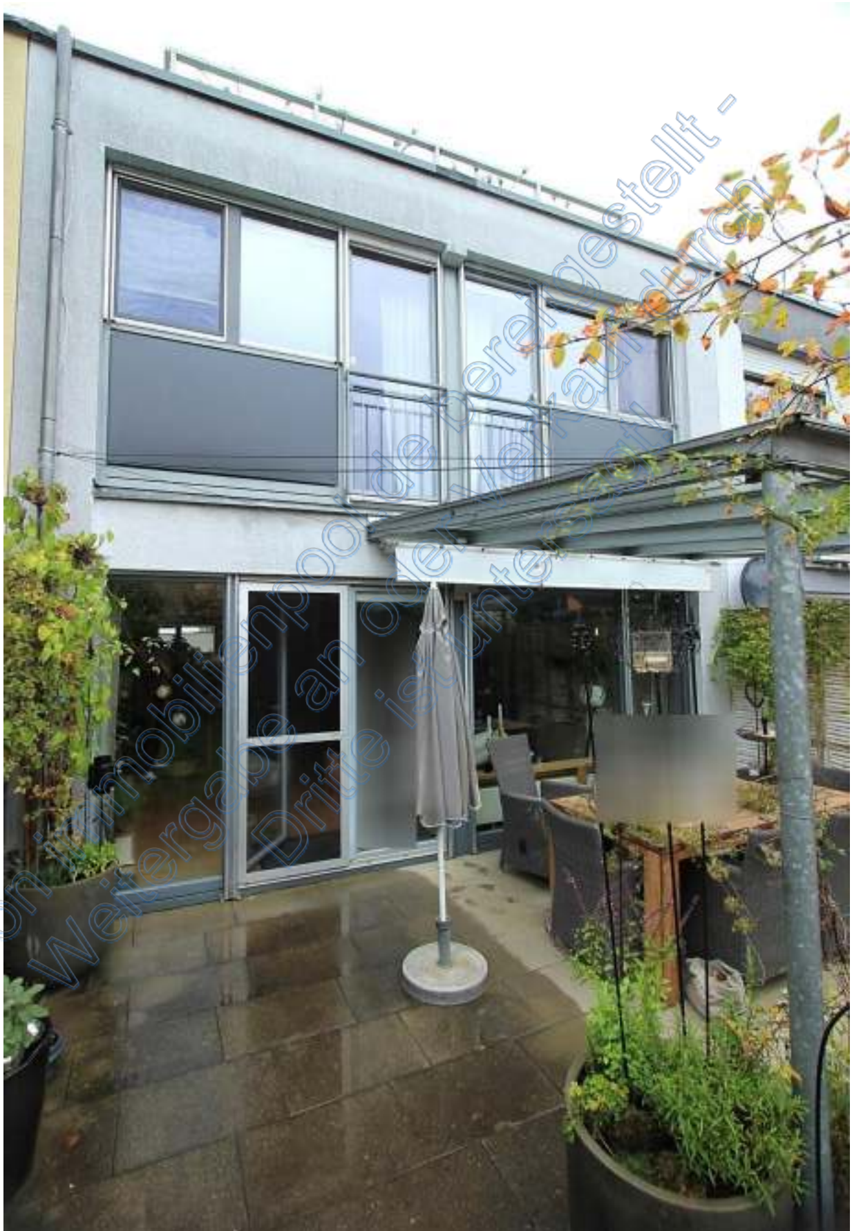
Überdachter Terrassenbereich und Südfassade Wohnhaus
