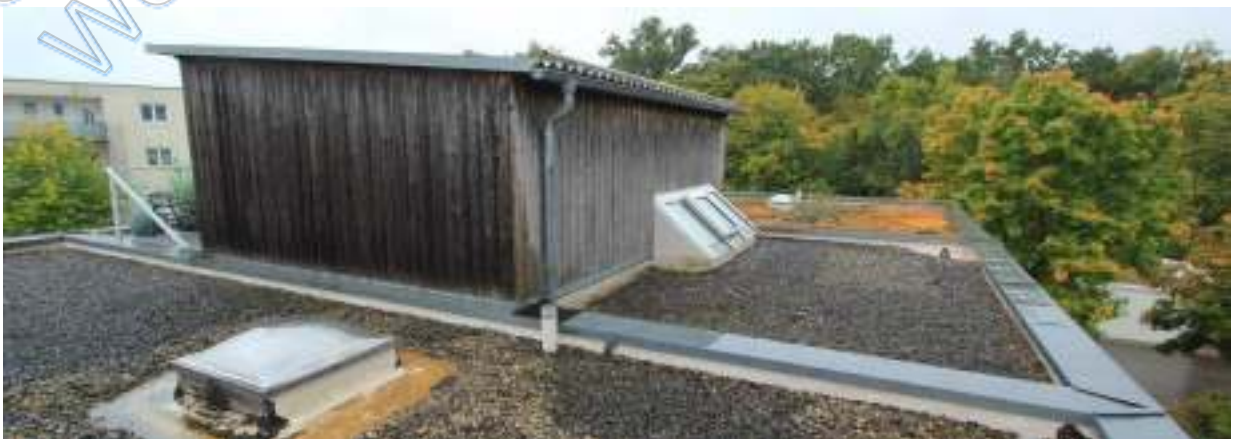
Dachaufbau von Nordosten, links Dachterrasse, rechts Oberlicht
