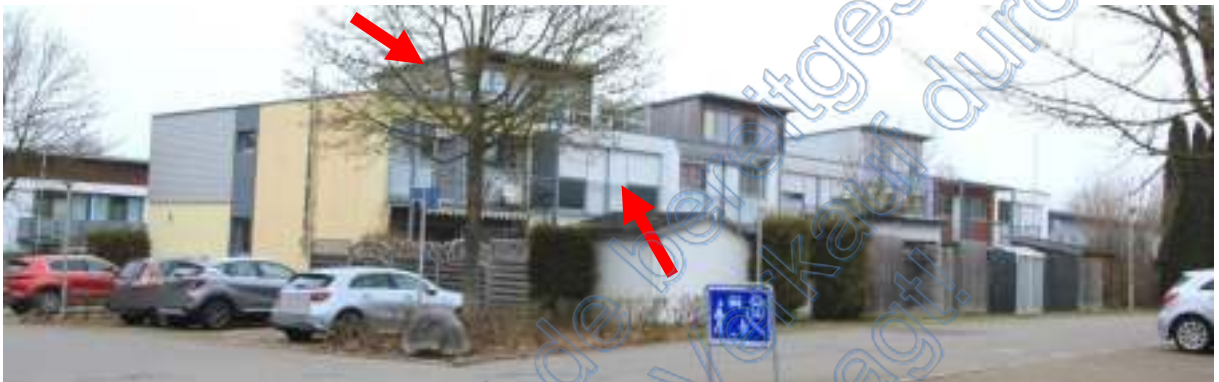
Reihenhausanlage von Südosten, Pfeil BV 1
