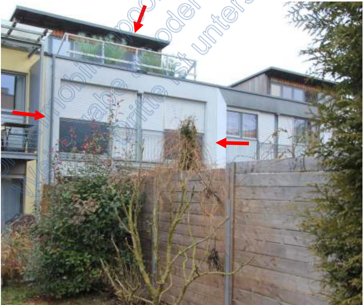
Südfassade Reihenmittelhaus 44 und Gartenzaun von Südwesten
