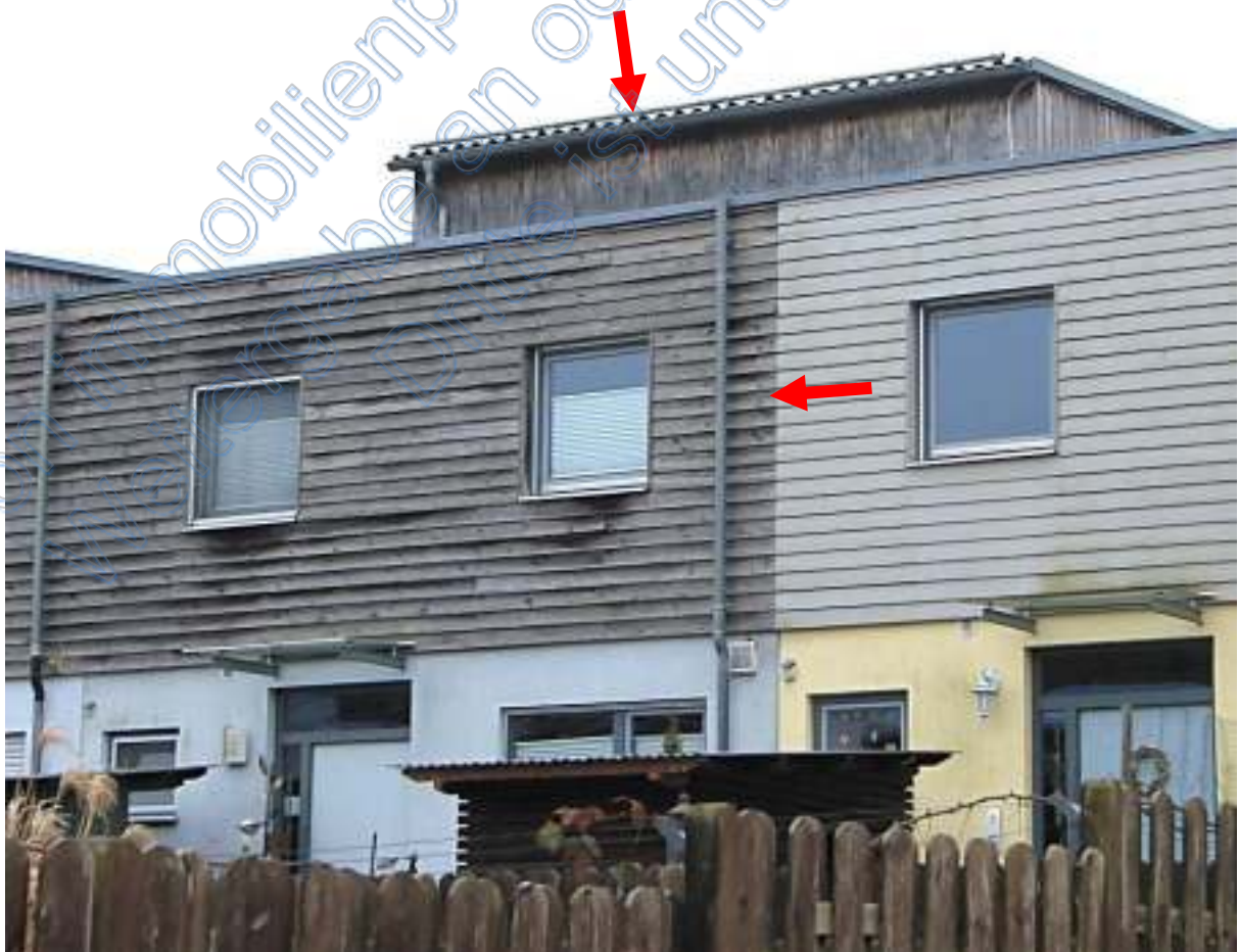
Rote Pfeile Reihenmittelhaus 44 von Nordwesten, oben Dachaufbau
