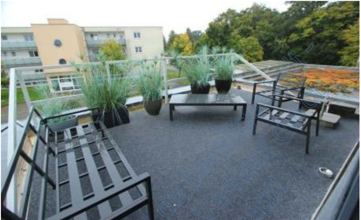
Dachterrasse nach Süden mit Geländer (nicht kindersicher)
