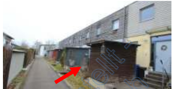
Fußweg zum Reihenhauses, Pfeil BV 1
