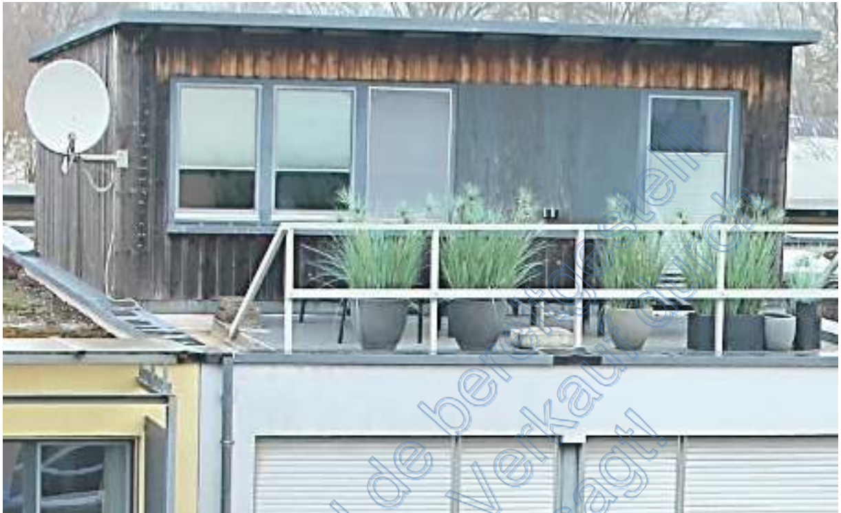
Dachaufbau mit Terrasse von Südwesten
