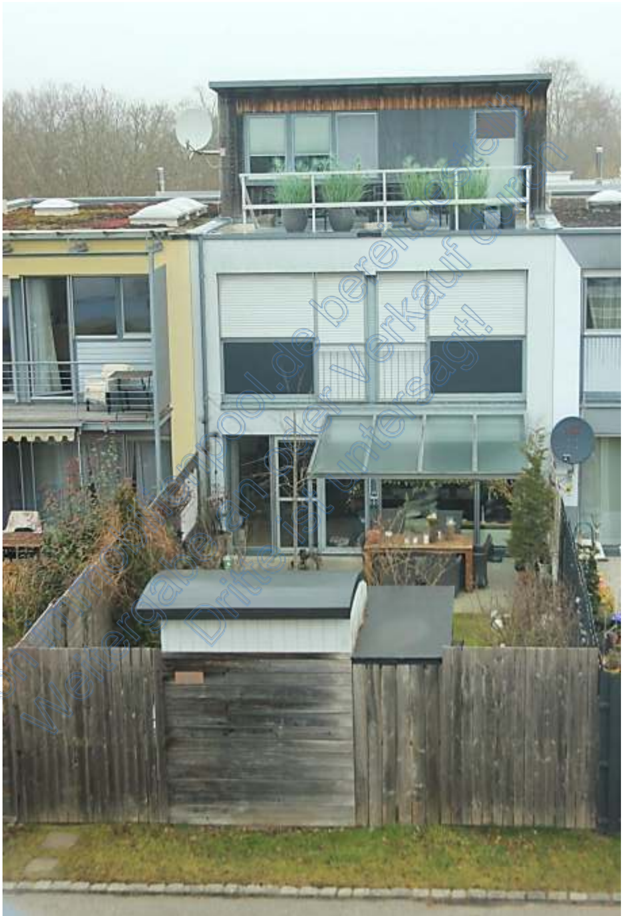
Südseite Reihenmittelhaus mit Terrassenüberdachung im EG, vorne Geräteschuppen
