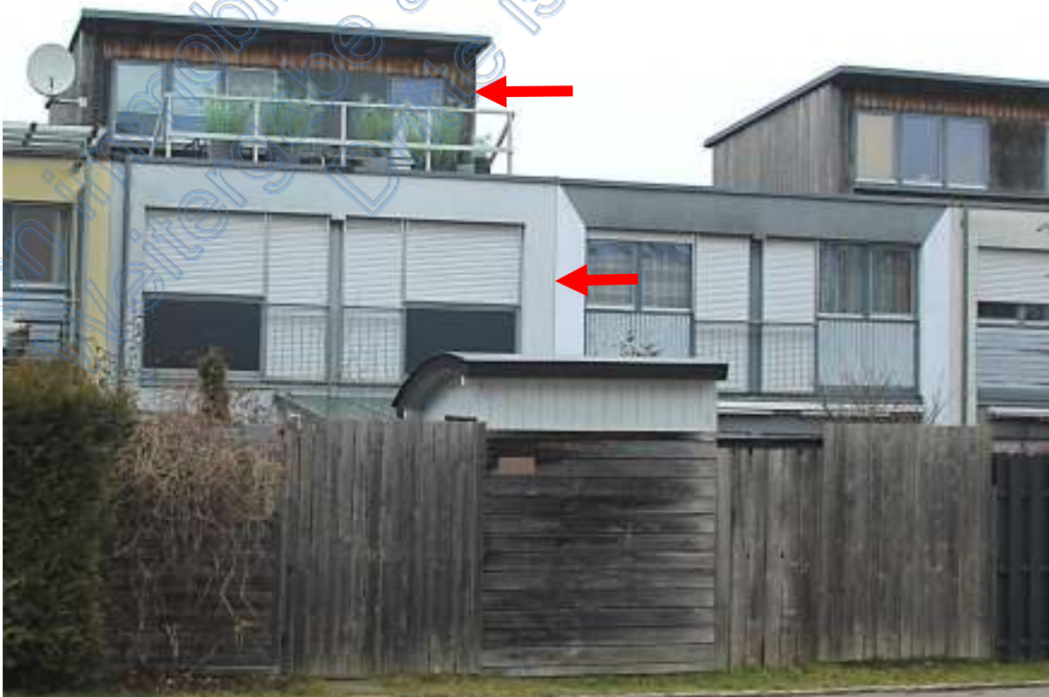
Grundstück Flst. 6721 mit Sichtschutzzaun, Geräteschuppen und Reihemittelhaus von Süden
