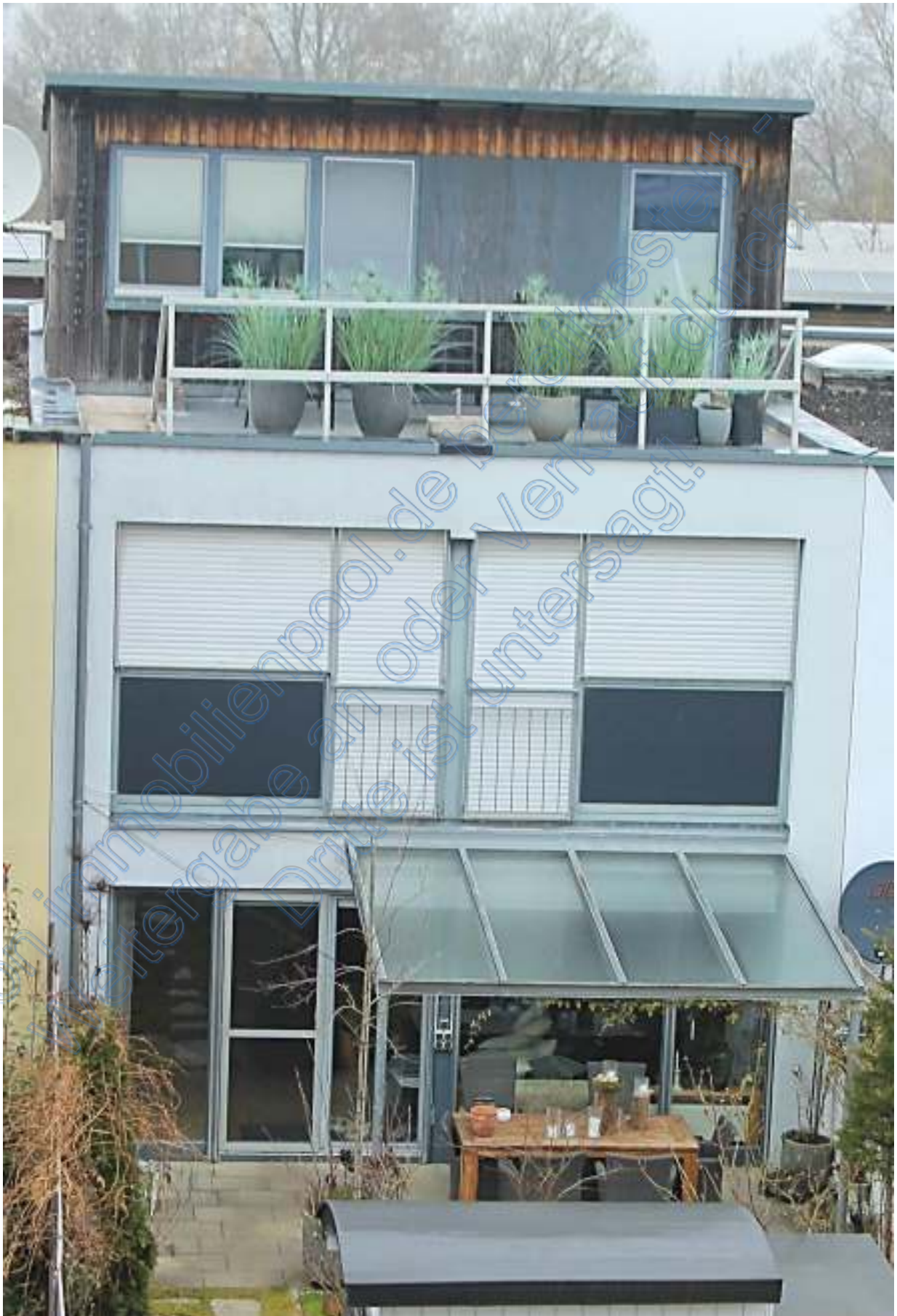
Südseite Reihenmittelhaus mit Dachterrasse und Terrassenüberdachung im EG
