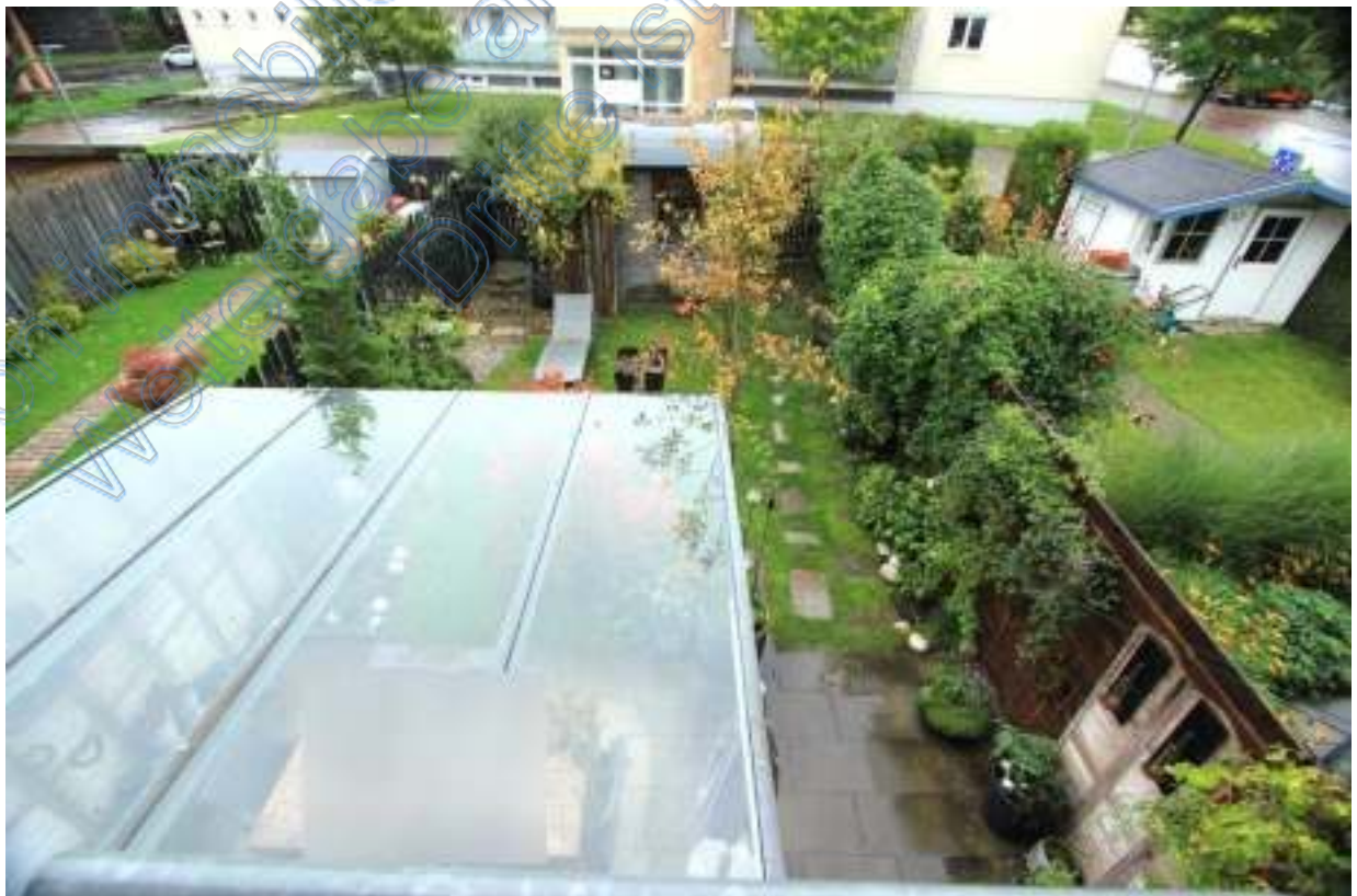
Südlicher Garten und Glasdach der Terrassenüberdachung von oben
