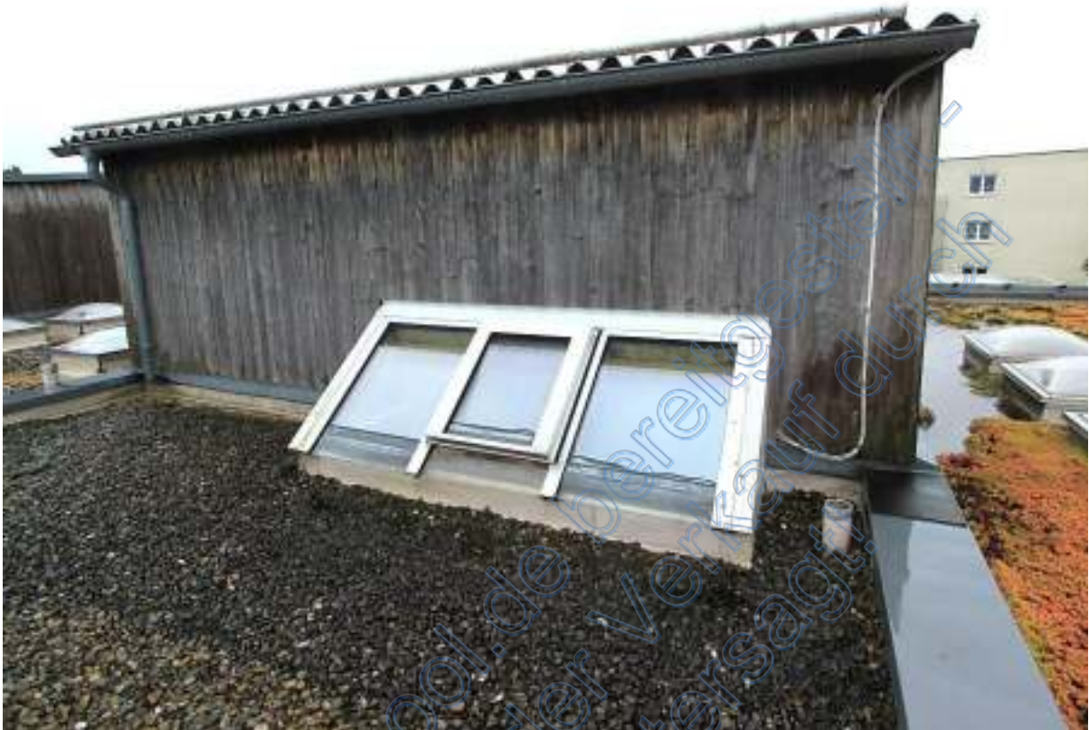
Nordseite Dachaufbau mit Oberlicht vom Bad im OG
