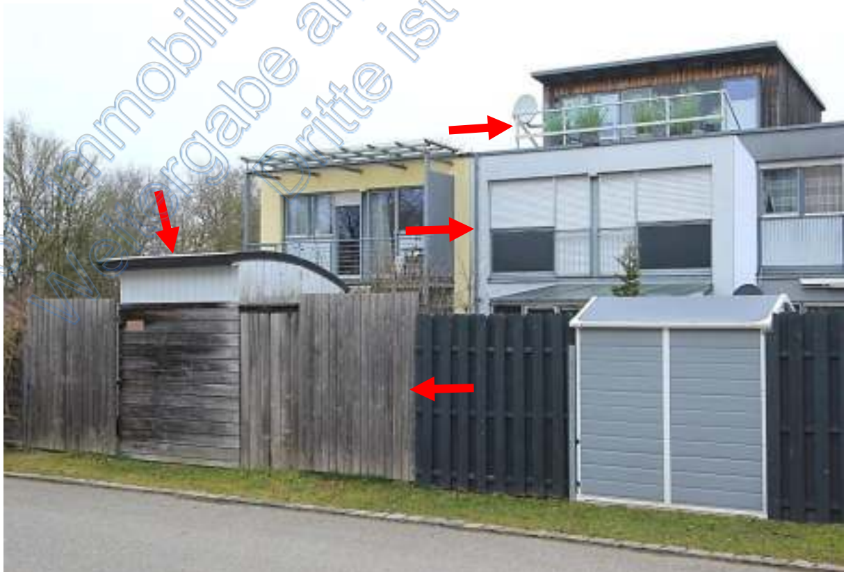
Grundstück Flst. 6721 mit Sichtschutzzaun, Geräteschuppen und Reihenhaus von Süden
