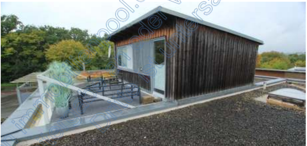
Dachaufbau von Südosten, links Dachterrasse
