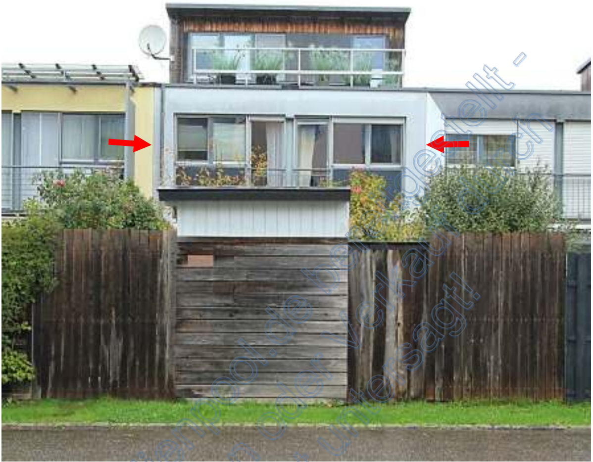
Südseite Reihenmittelhaus 44 BV 1, davor Gartensichtschutzzaun
