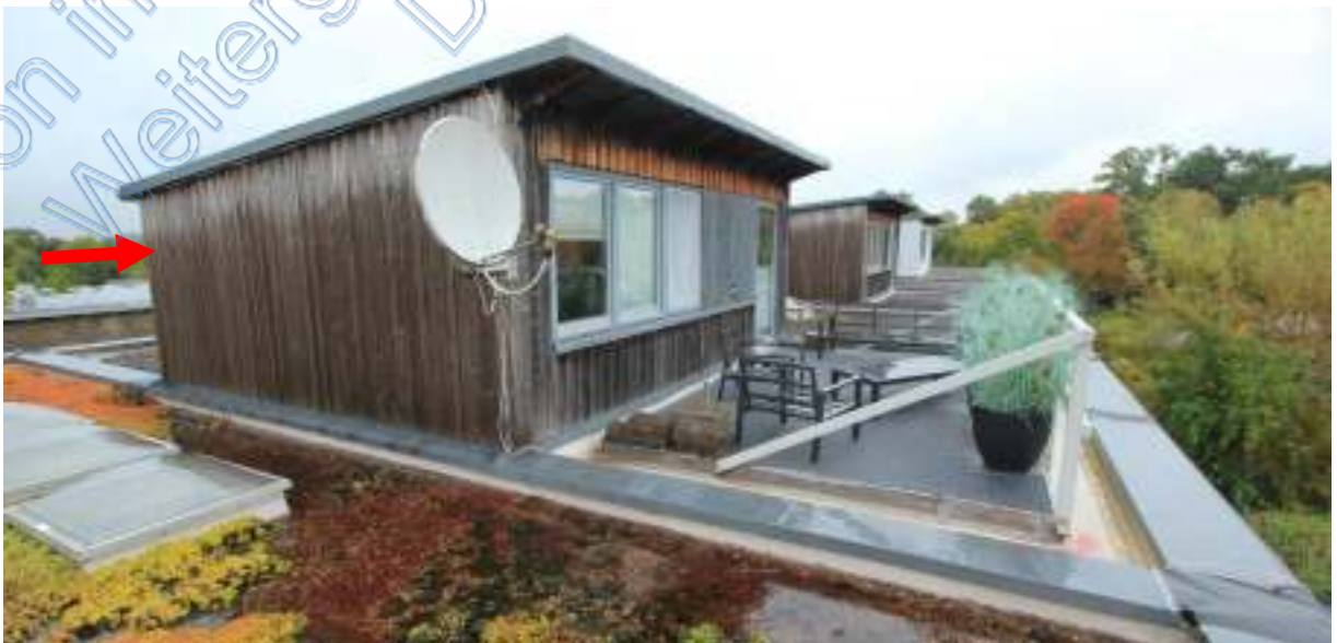
Dachaufbau von Westen, rechts Dachterrasse
