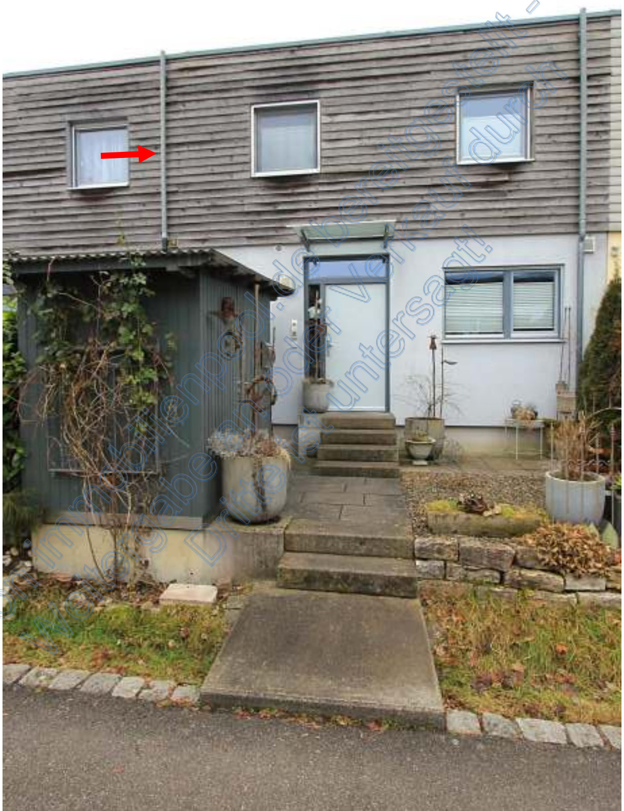
Nordansicht Reihenhaushaus BV 1 mit Hauszugang, links Geräteschuppen
