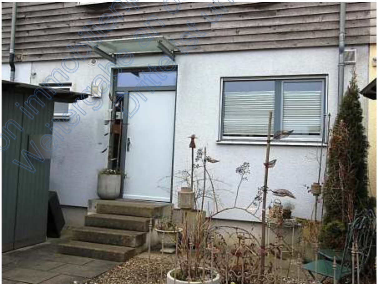
Putzfassade im EG mit Hauseingangstür
