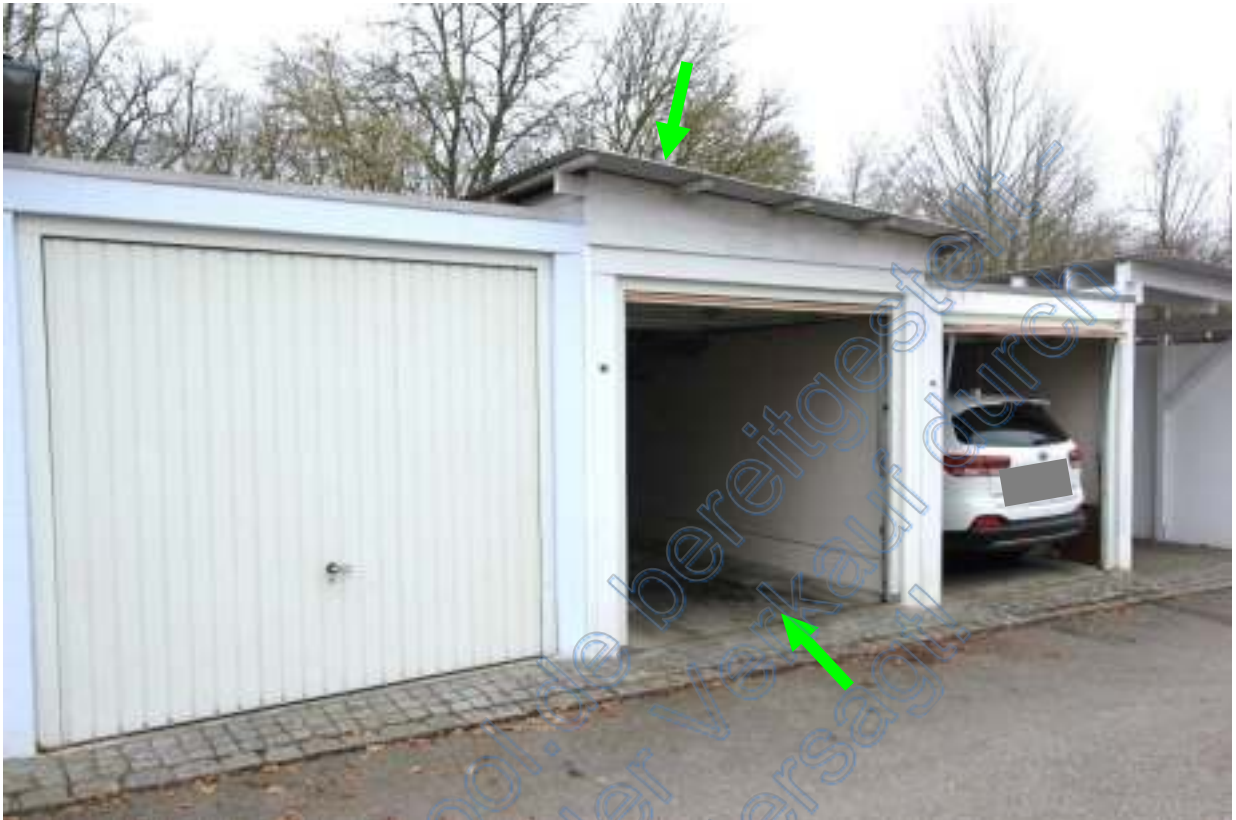
Blick von Südosten, Pfeil Garage 56/32 auf Flst. 6708
