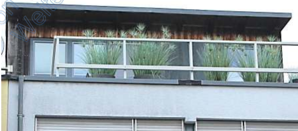
Dachaufbau von Süden mit Terrassengeländer
