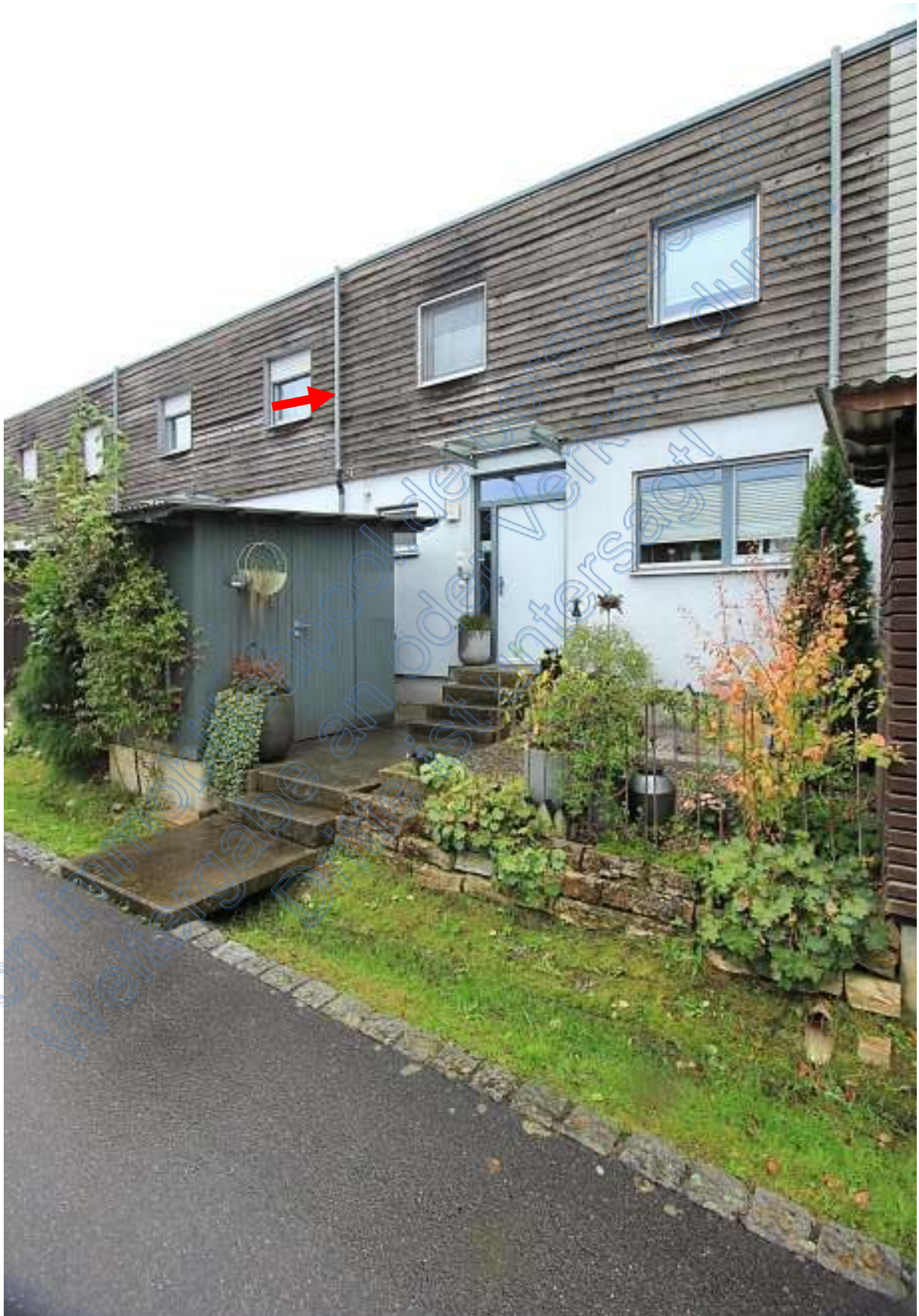
Nordseite Reihennittelhaus 44 BV 1 mit Hauseingang und Geräteschuppen
