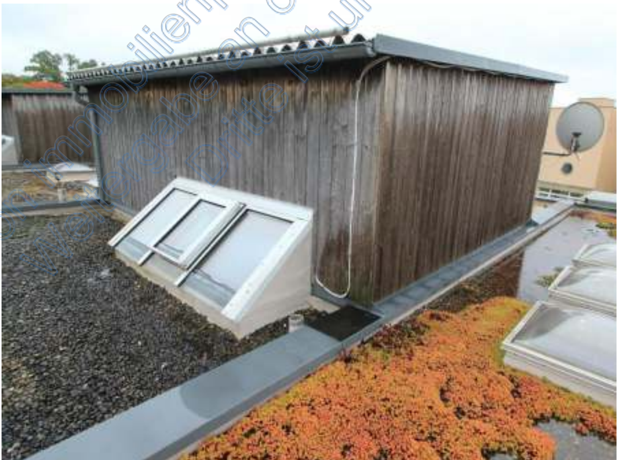
Dachaufbau von Nordwesten mit Oberlicht
