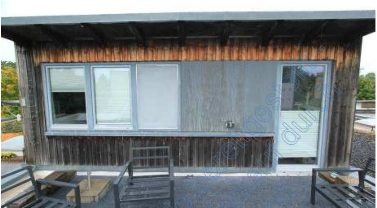
Südseite Dachaufbau mit Terrassentür zum Treppenhaus (rechts)
