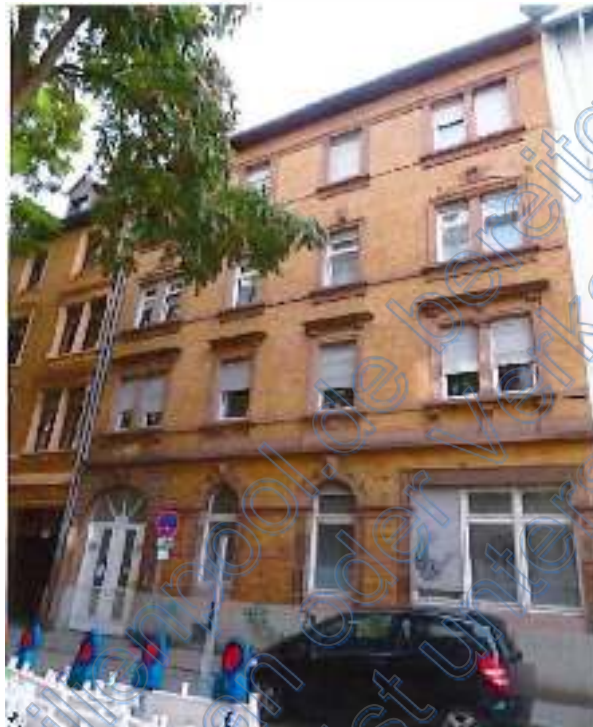
Foto 1: Ansicht von der Straße aus
