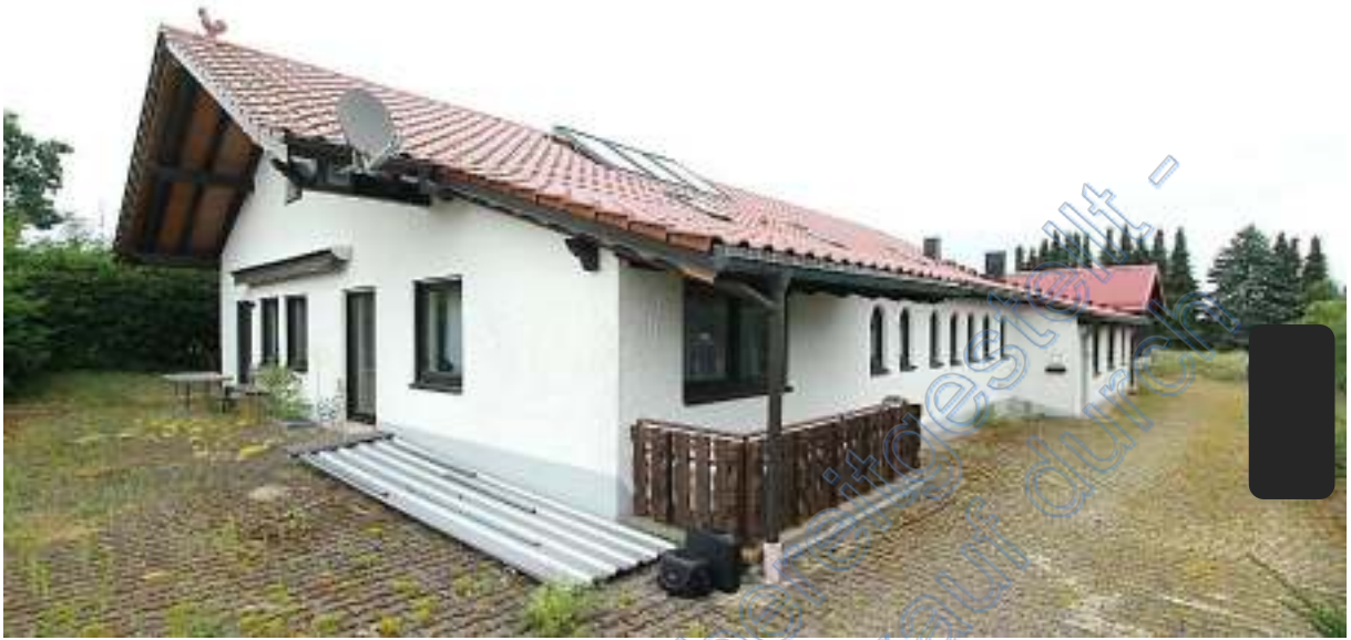
Wohnhaus von Südwesten, vorne Geländer Kelleraußentreppe
