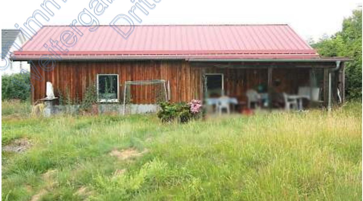
Ostseite Garagen/Lagergebäude, rechts angebauter Unterstand (überdachter Sitzplatz)
