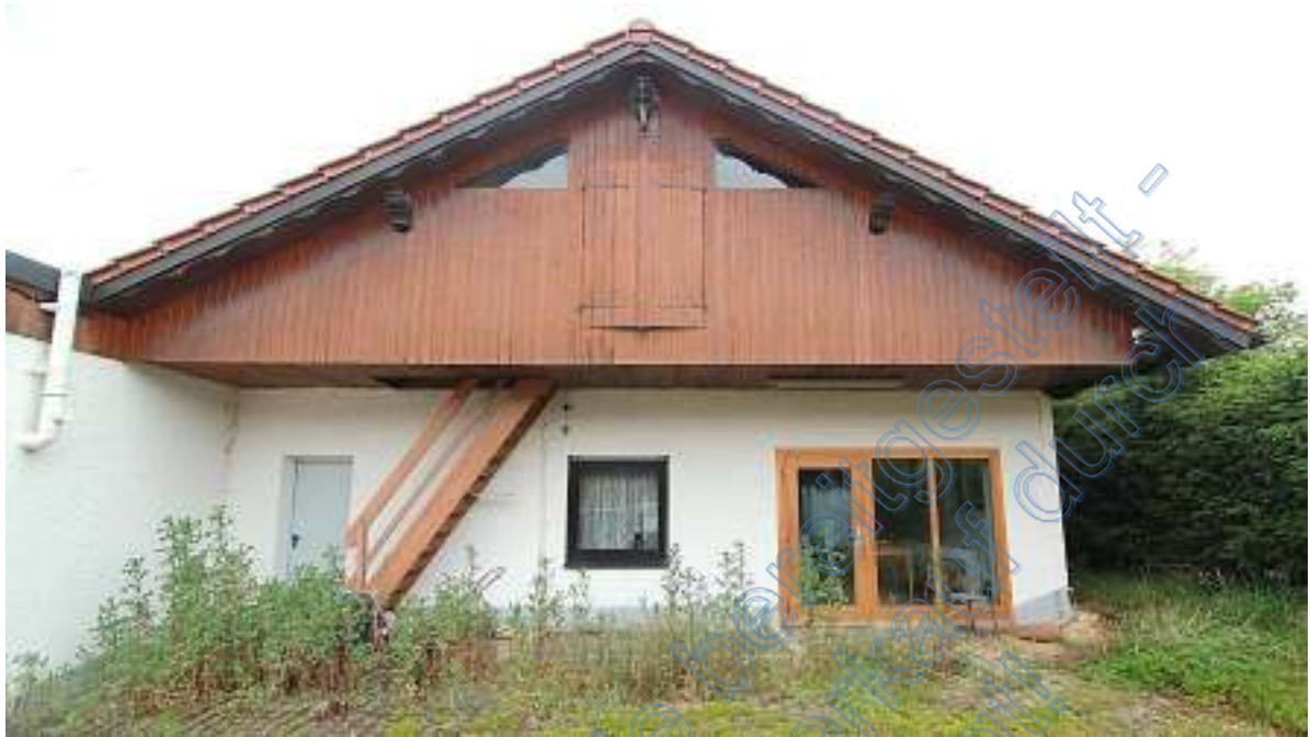
Ostgiebelseite Wohnhaus, mit steiler Holzterasse zum DG
