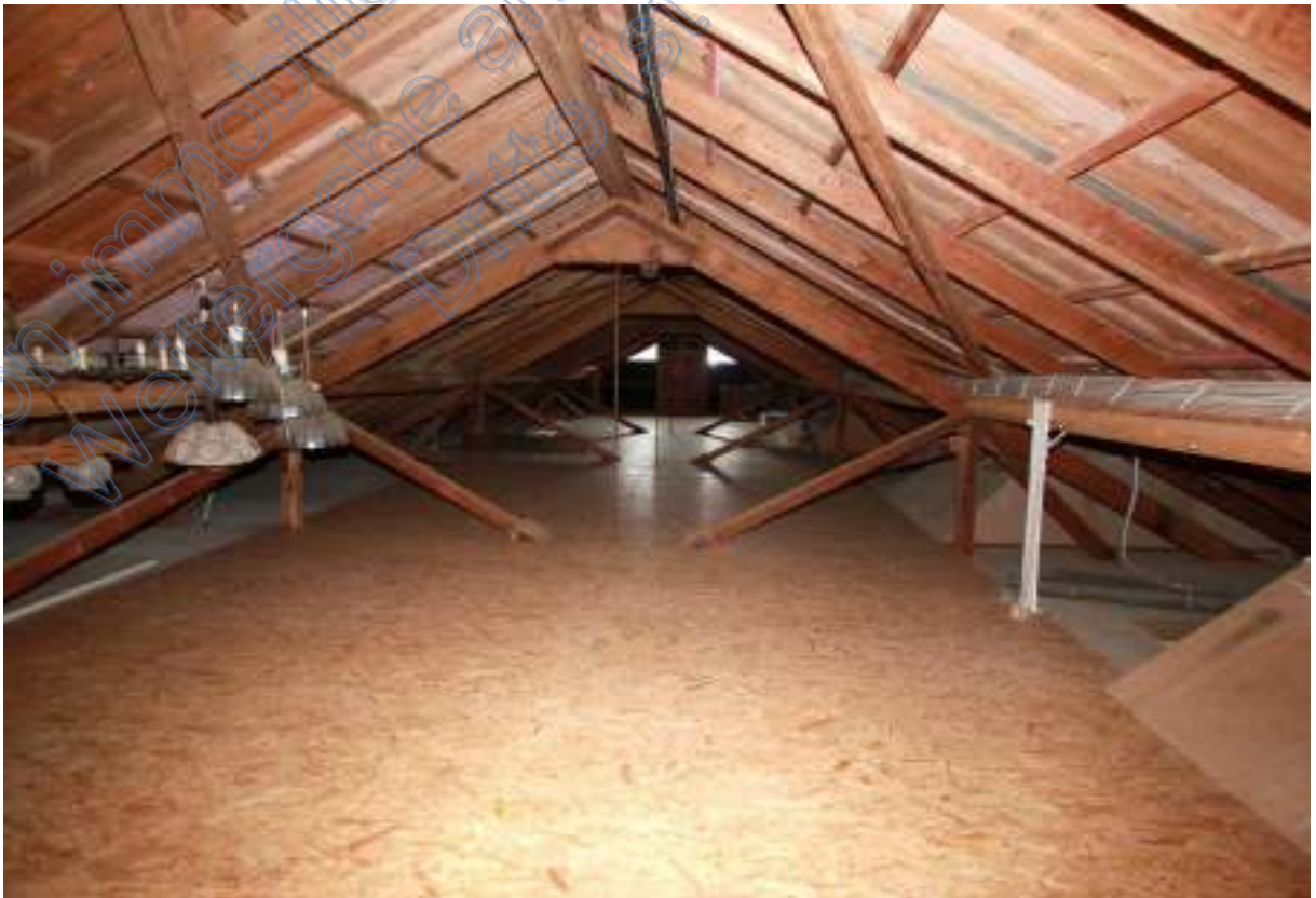
Bühne im DG, Blick nach Osten
