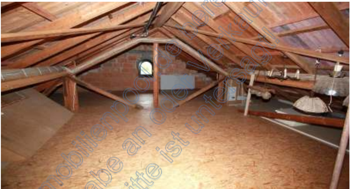
Bühne im Dachgeschoß, Blick zur Westgiebelwand
