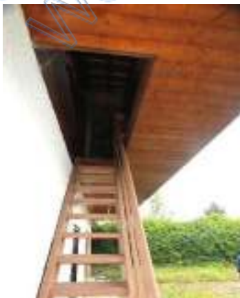
Bodenluke außen zum Dach
