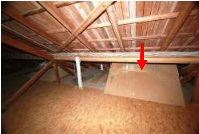
DG, Pfeil Verkleidung Dachfenster vom EG-Raum
