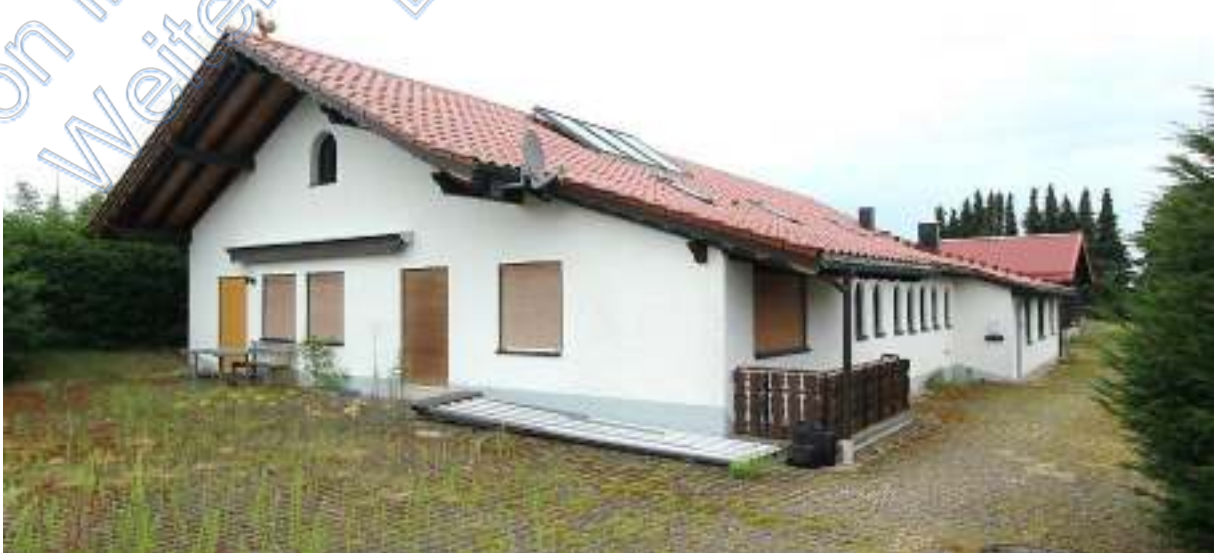
Wohnhaus mittig auf dem Grundstück von Südwesten
