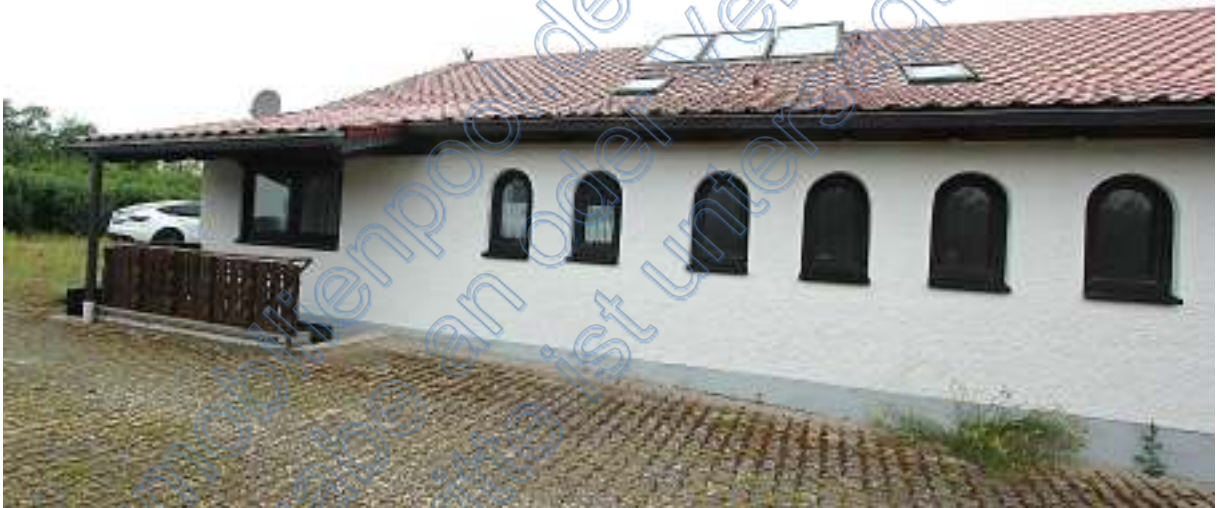
Südfassade Wohnhaus, links Kelleraußentreppe
