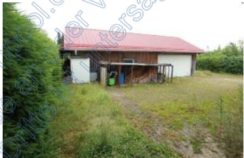
Hof westlich vor dem Garagengebäude
