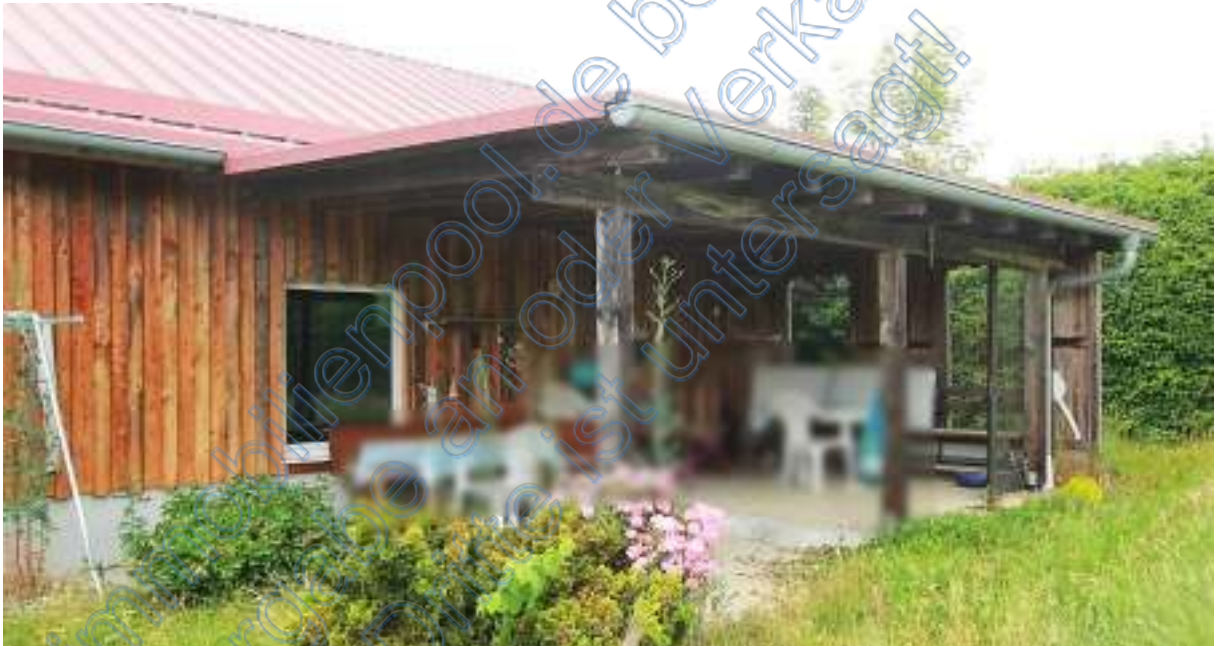
Nördlicher Teil Garagen/Lagergebäude mit überdachtem Sitzplatz
