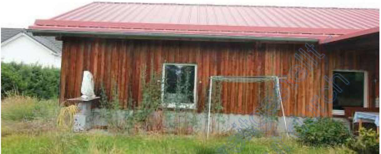
Südliche Ostfassade Garagen/Lagergebäude
