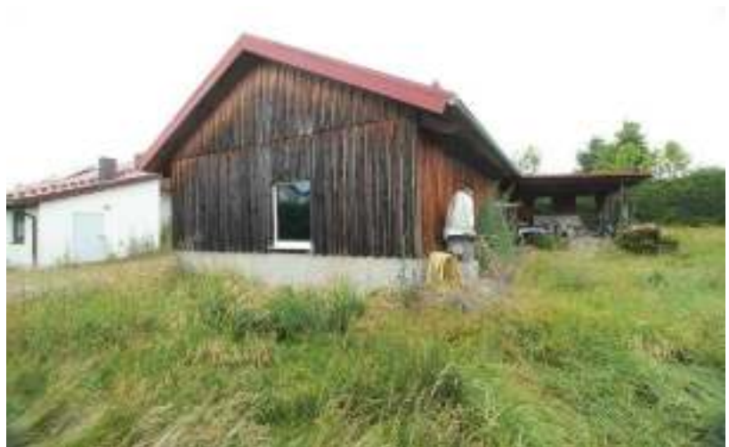
Garagen/Lagergebäude von Süd/Südosten
