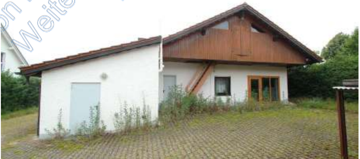
Ostseite Wohnhaus, links Heizungsraum
