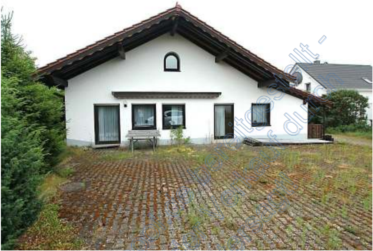
Westgiebelseite Wohnhaus mit gepflastertem Hof
