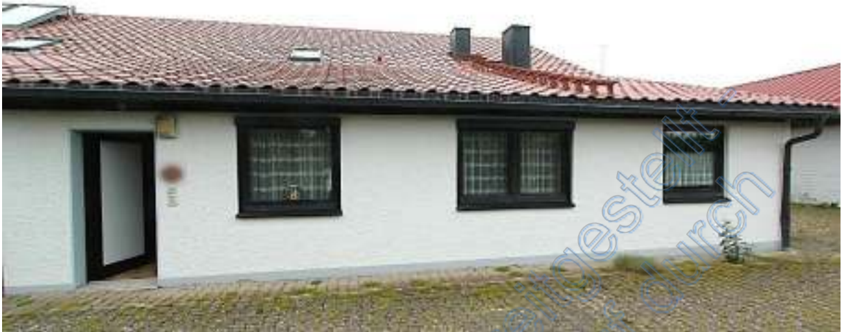
Südfassade Wohnhaus östlicher Bereich, links Hauseingang
