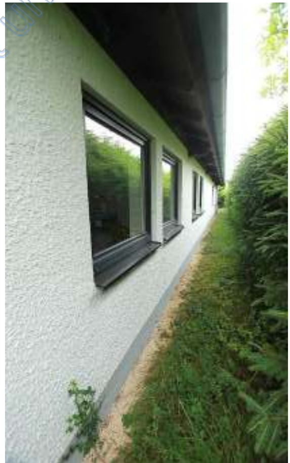
Nordseite Wohnhaus von Osten
