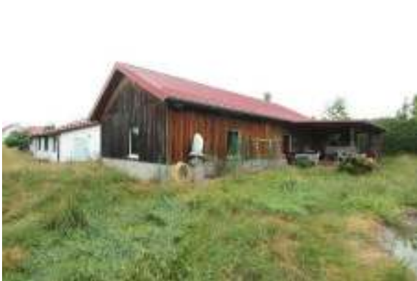
Grünland mit Garagengebäude von Südosten
