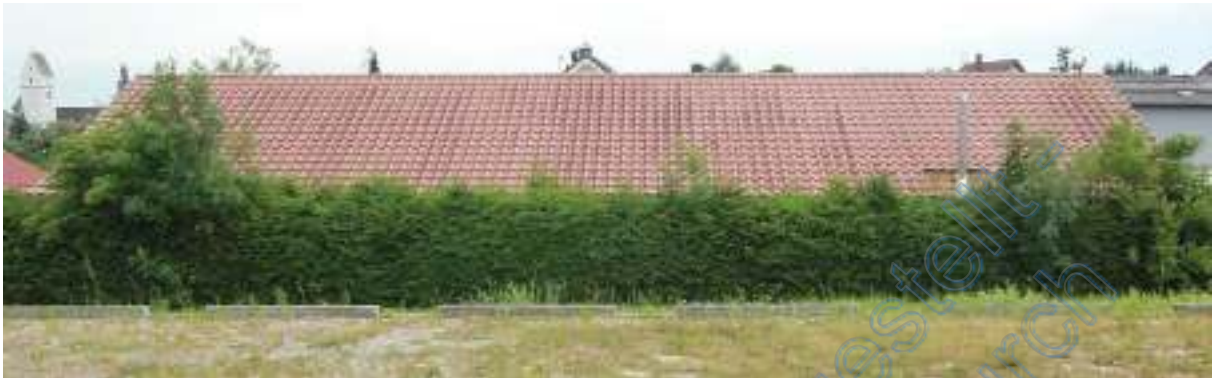
Wohnhausdach von Norden, davor Randbepflanzung aus Nadelbäumen
