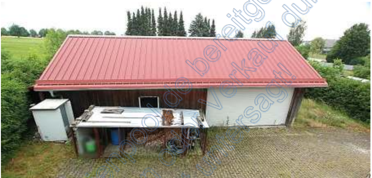
Garagen/Lagerhalle von Osten und von oben
