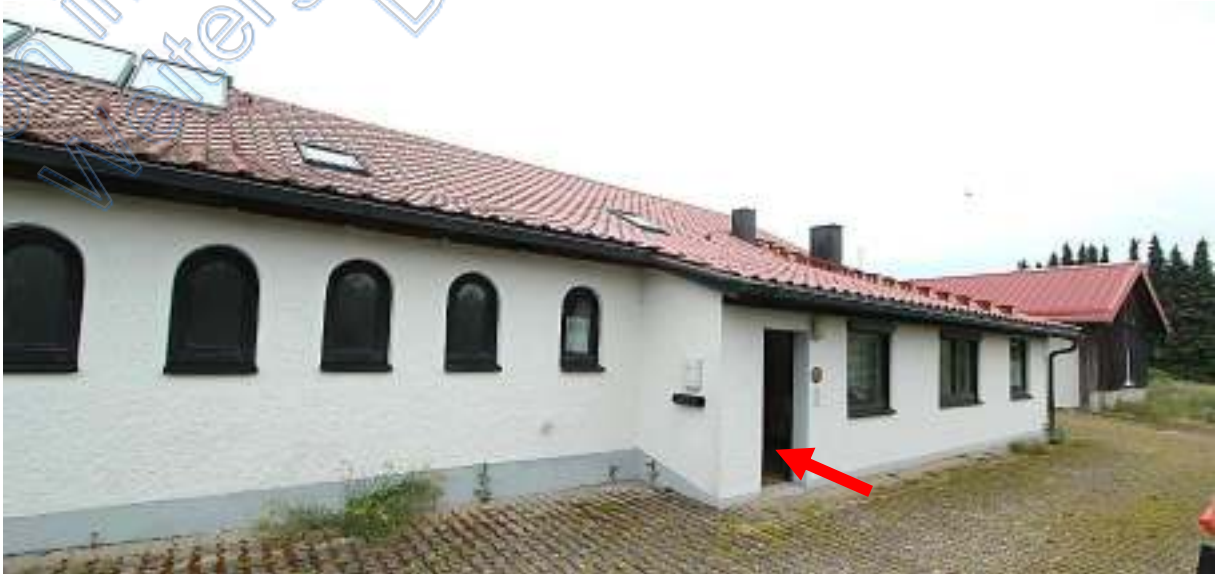
Südfassade Wohnhaus, Pfeil Hauseingang
