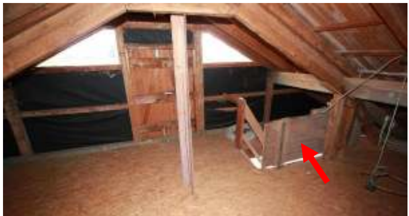
Dachspitz, Pfeil Bodenluke im Osten
