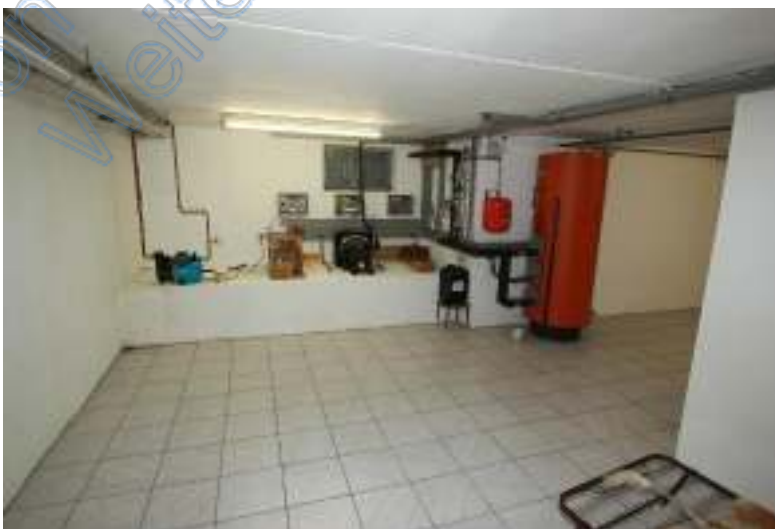
Großer Keller, westlicher Bereich
