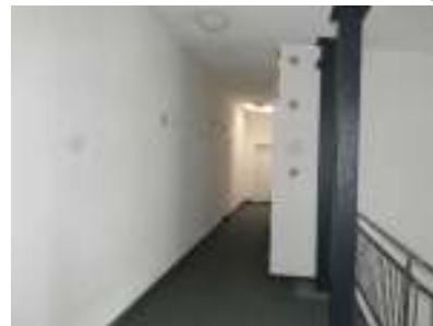
Flur DG Richtung Wohnung T 4.3
