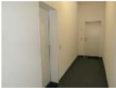
Eingangstür Wohnung T 4.3 (links)
