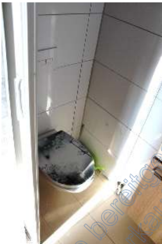
Foto 8: Gäste WC im EG des Wohnhauses
