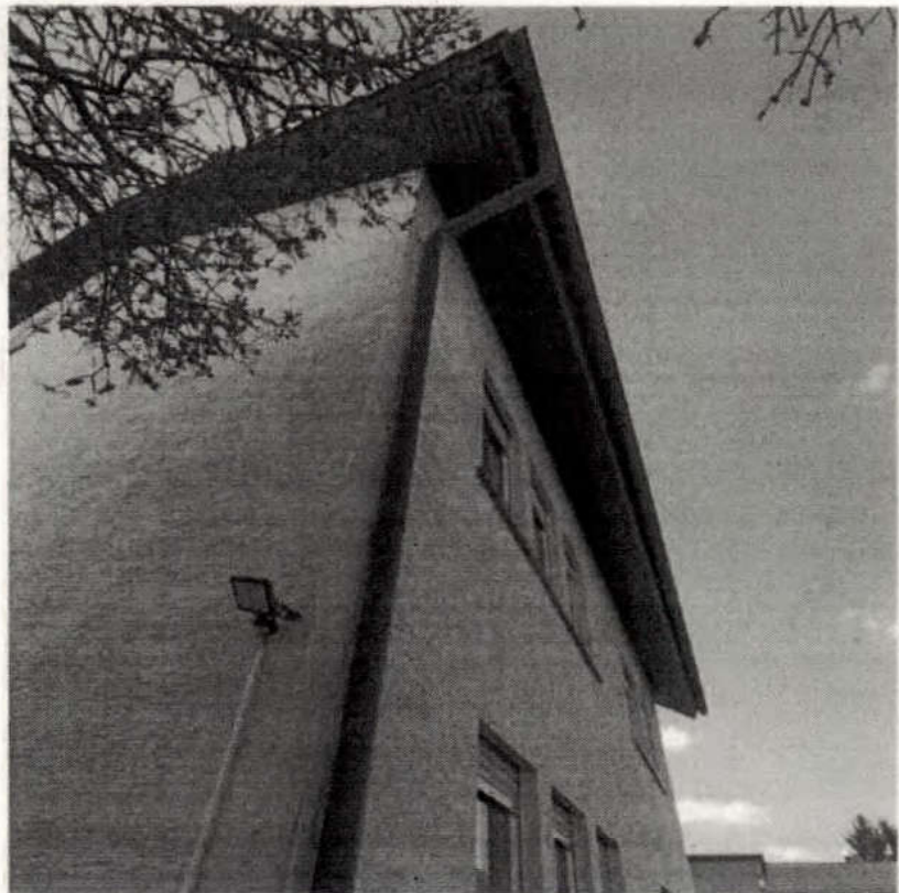
Östliche Gebäudeecke mit Fassade, Dach- untersicht und Fallrohr Dachent- wässerung
