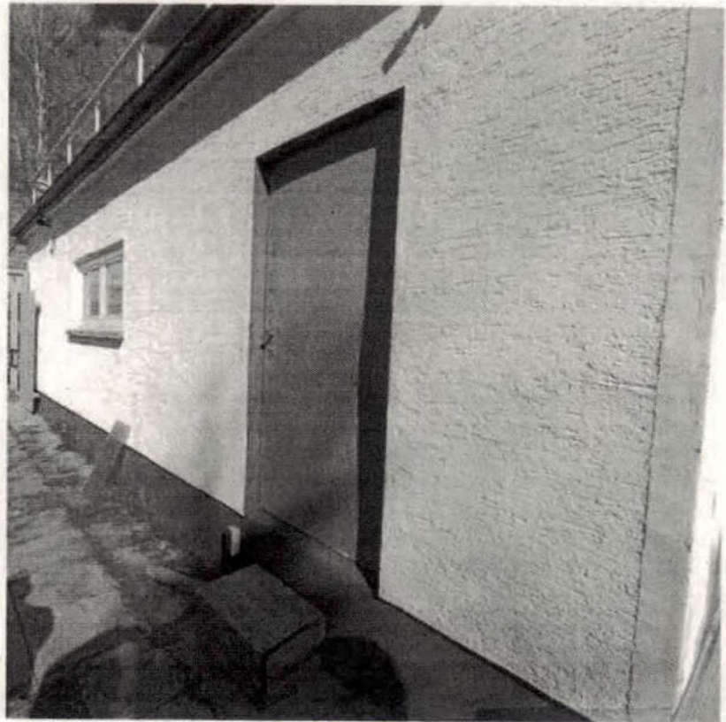
Garage von Westen, mit Zugang zum südwestlich ange- bauten Öltankraum
