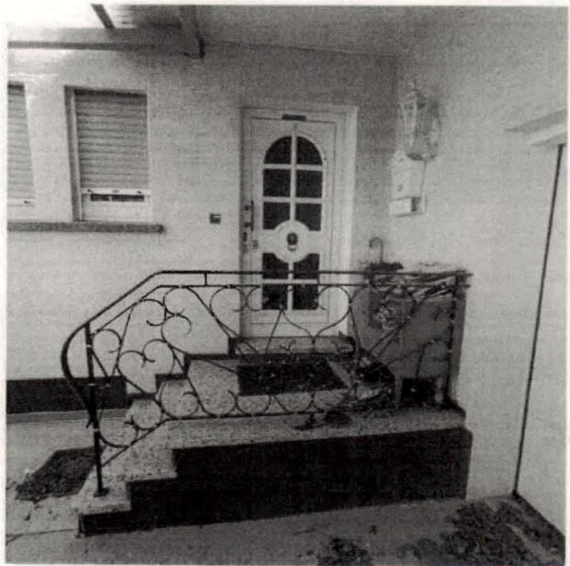
Hauseingangstür auf nordwestlicher Giebelseite, rechts angebaute Garage
