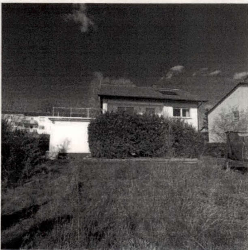
Ansicht von Süd- westen (Gartenseite)
