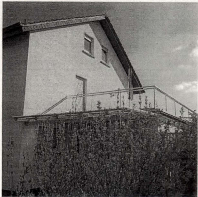
Ansicht nordwestliche Giebelseite
