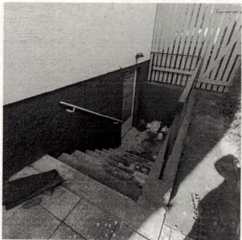
Kelleraußentreppe auf südöstlicher Giebelseite
