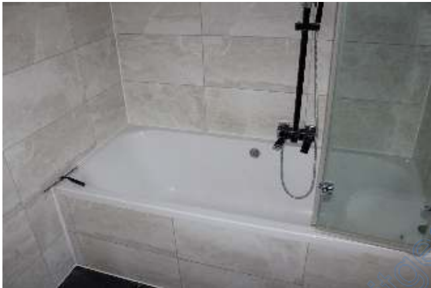
Foto 17: Badezimmer der Wohneinheit Nr. 1 im 2. OG
