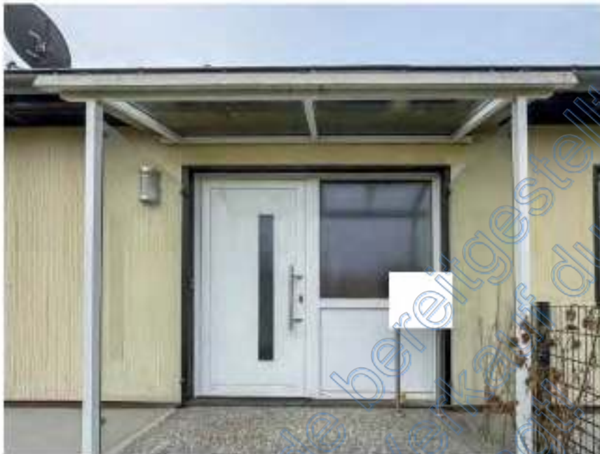
Bild 5: Eingangstüre und -überdachung
