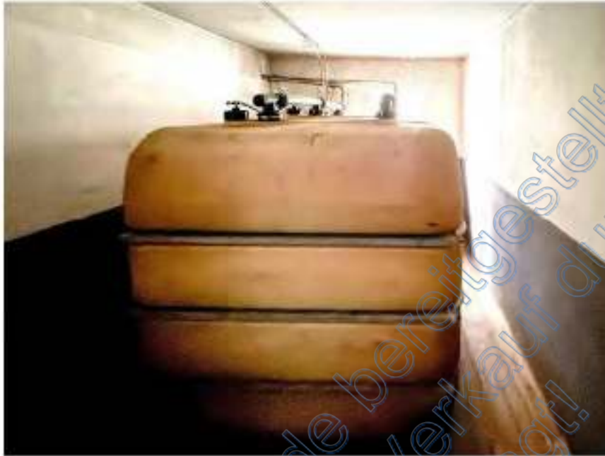
Bild 29: Heizöltank
