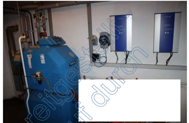
Heizungsanlage und Wechselrichter
